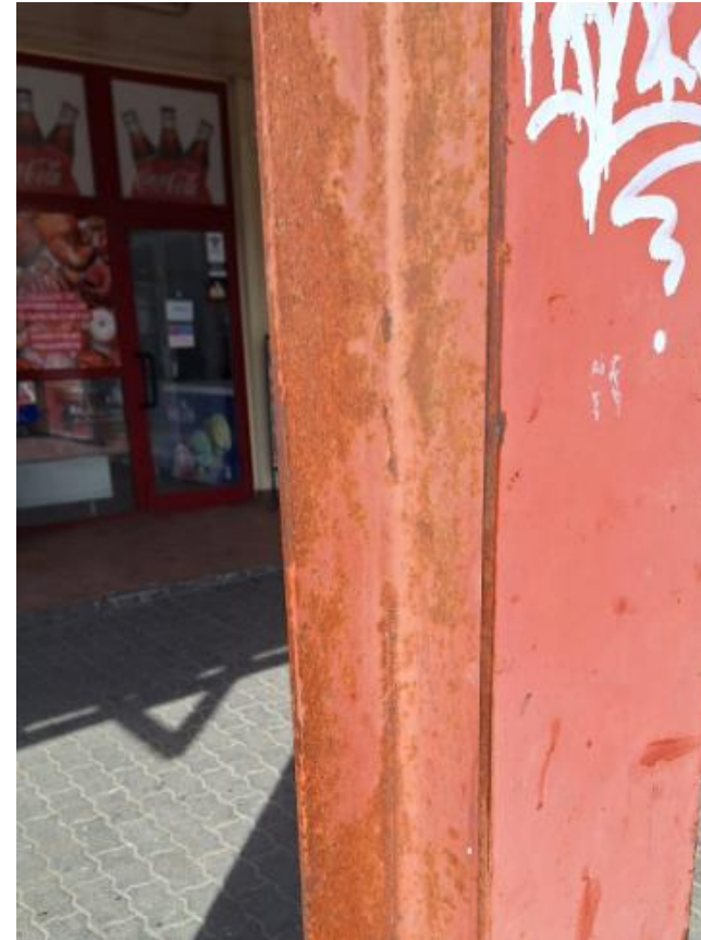
Grosimea stratului de vopsea/rugină este de 21,2 microni . Coroziunea este evidentă și acoperă arii întinse
