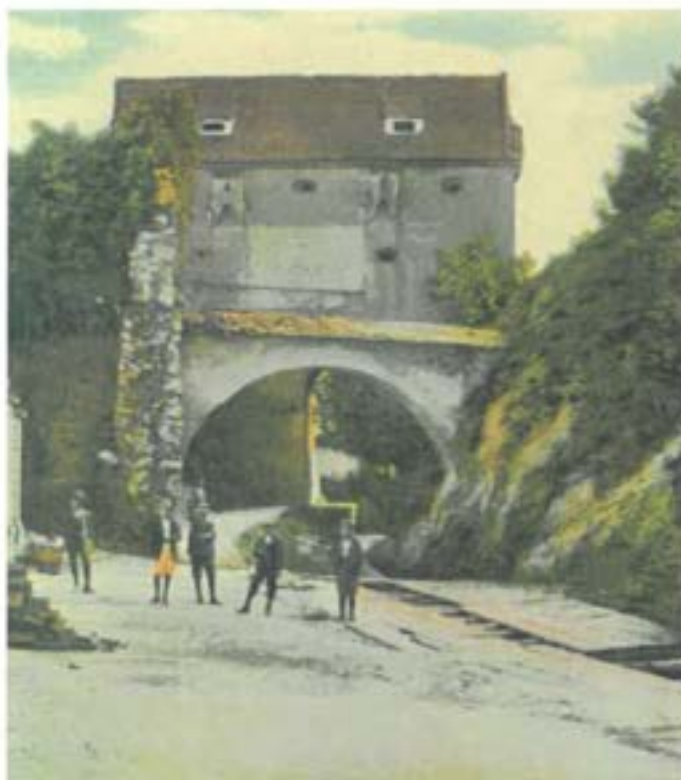
Imagine de început de sec. XX, anterior construirii vilei din vecinătate. Zona de la baza versantului, respectiv albia Graftului, este parțial acoperită cu plăci de lemn ("foaștăna"), erau montate transversal pe niște grinzi de lemn. Scândurile sunt montate orizontal, pe grinzi de lemn, formând o platformă destul de lată. Restul canalului este lăsat descoperit, cu apă curgătoare vizibilă la dreapta. Posibil fază de organizare de șantier pentru construcția vilei lui Herman Czell.
