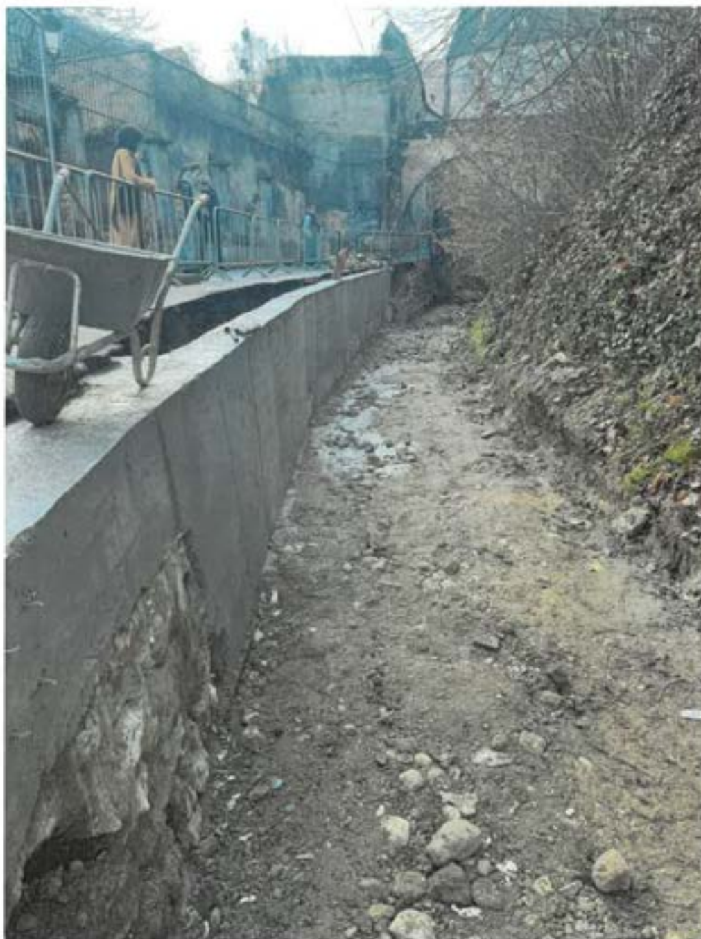
Foto nr. 8 - segment 2 - Elevatia noului zid realizat din beton armat C 30/37
