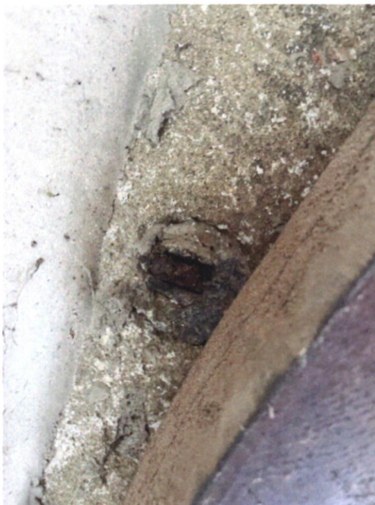
Detaliu al sistemului de prindere a cadrului de lemn al ușii prin elemente metalice încastrate în molonul din piatră.
