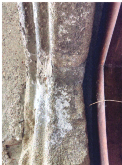
În partea dreaptă a portalului cadrul de lemn al ușii este prins în zidăria bastionului amplasat la o mică distanță de ansamblul litic.
