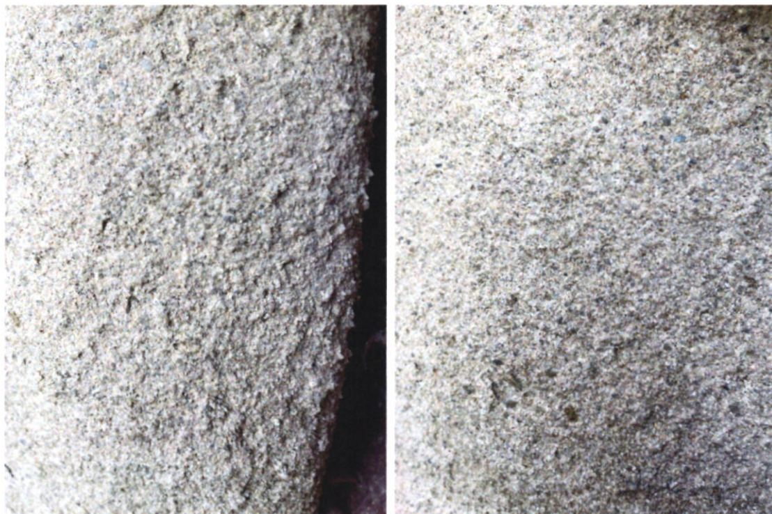
Detalii macro ale aspectului suprafeței litice ca urmare a fenomenului de dezagregare granuară.
