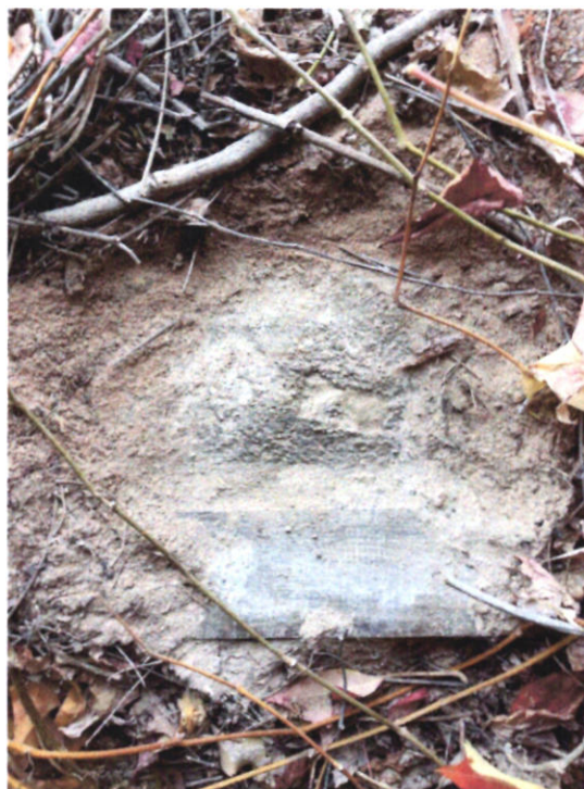
Pragul de jos al ușii este din lemn încastrat în mortarul tencuielii zidăriei. Nu se întâlnesc elemente litice ce fac parte din ansamblul portalului.
