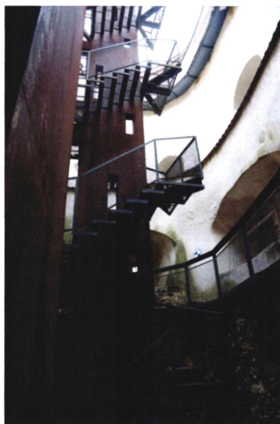
Scara de acces între nivele a turnului interior.
