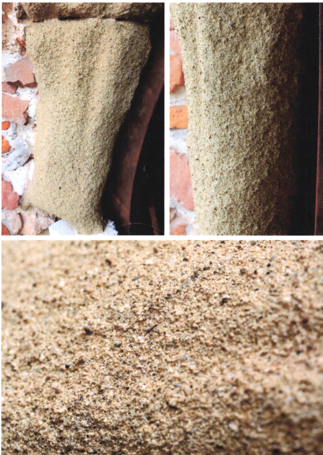
Imagini macro ale suprafeței litice acolo unde este vizibilă dezagregarea granulară și apariția unei suprafețe aspre, erodate.
