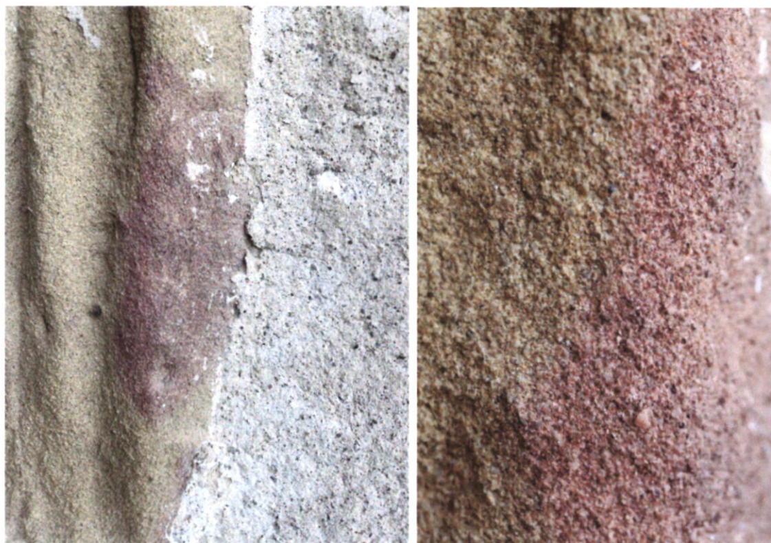
În partea dreaptă a portalului se poate observa o suprafață de culoare roșiatică, datorată acumulării oxizilor de fier în procesul de formarea a rocii.
