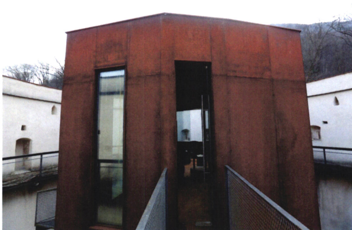
Partea superioară a turnului interior construit din panouri de din oțel Cor Ten
