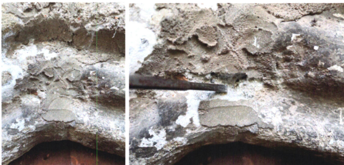
Îndepărtarea prin metode fizico-mecanice a stratului de reparație cu mortar dur, pe bază de ciment.
