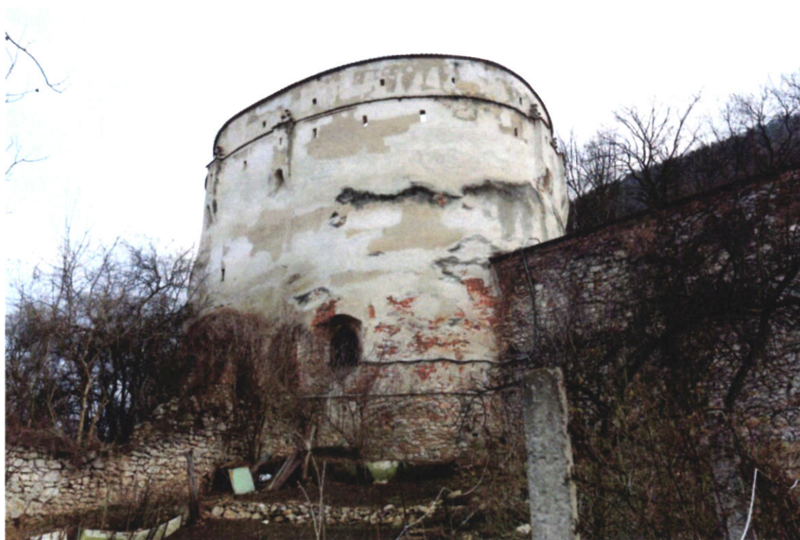
Turnul Postăvarilor, ușa de acces și porțiuni ale zidului Cetății - vedere dinspre vest
