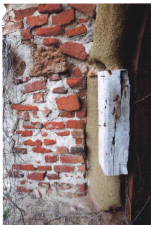
Detalii ale elementelor decorative din piatră ale portalului. Acesta este încadrat în zidăria de îmbinare a zidului bastionului cu zidului cetății. În partea superioară se mai păstrează profilatura pe rotund, în timp ce la nivelul inferior moloanele de piatră sunt puternic erodate și prinse cu bucăți de lemn.
