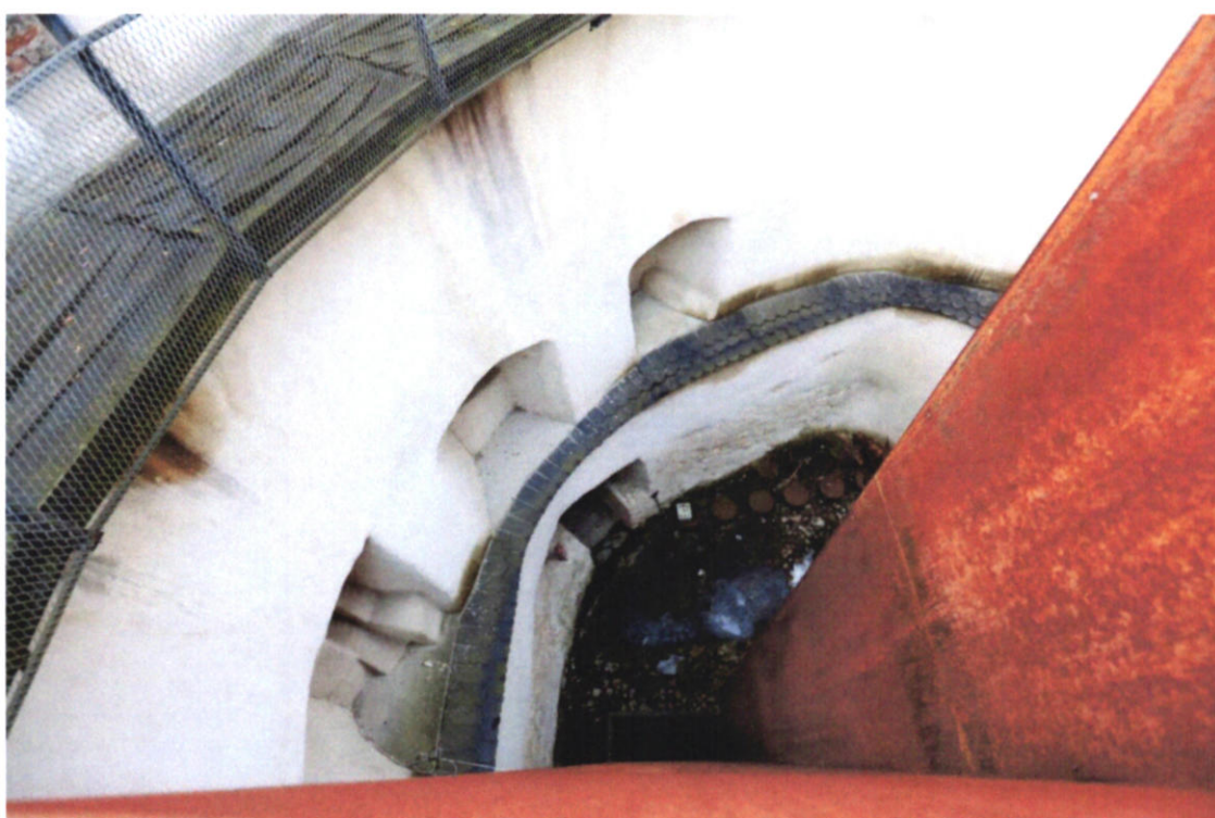
Bastionul Postăvarilor (interior) cu vedere spre nivelurile inferioare
