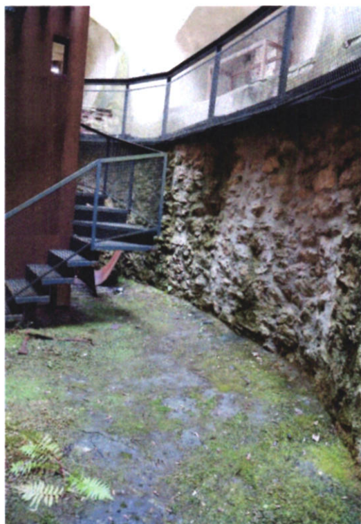
Pereții Clădirii C II – situați sub nivelul parterului. Pereții nu au fost tencuiți, doar au fost refăcute mortarele de rost ale zidăriei din blocuri de piatră.
