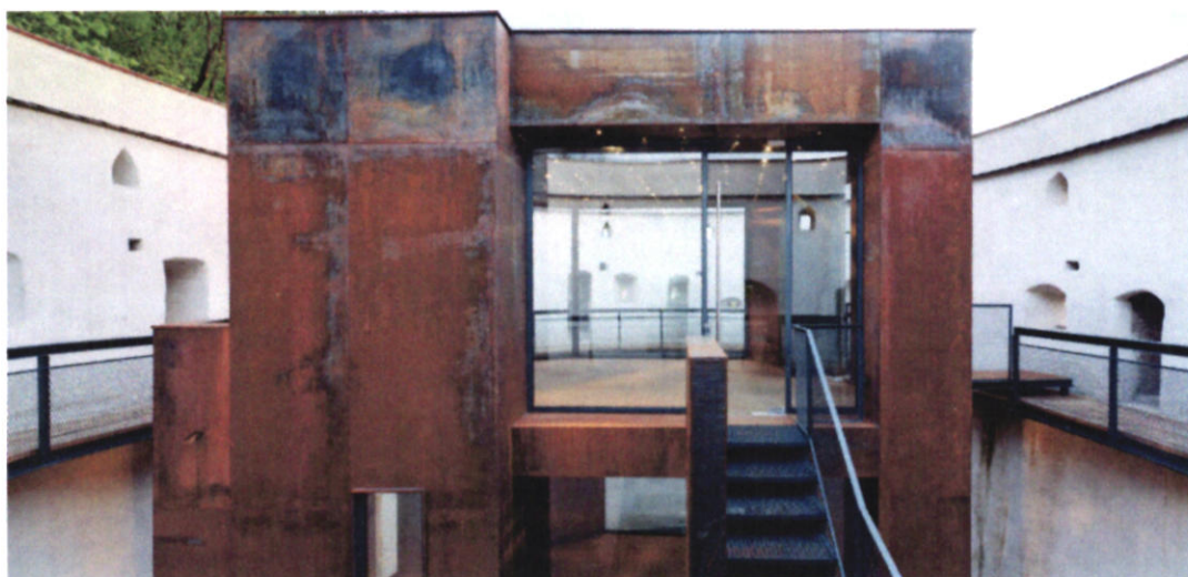
Fotografii realizate la momentul intervenţiilor din 2010. Se refac tencuielile zidăriei din interiorul bastionului, se realizează turnul din interior din oţel Cor Ten, se refac drumurile de strajă.
