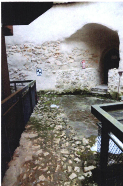
Pavajul interior din piatră al nivelului de călcare original
