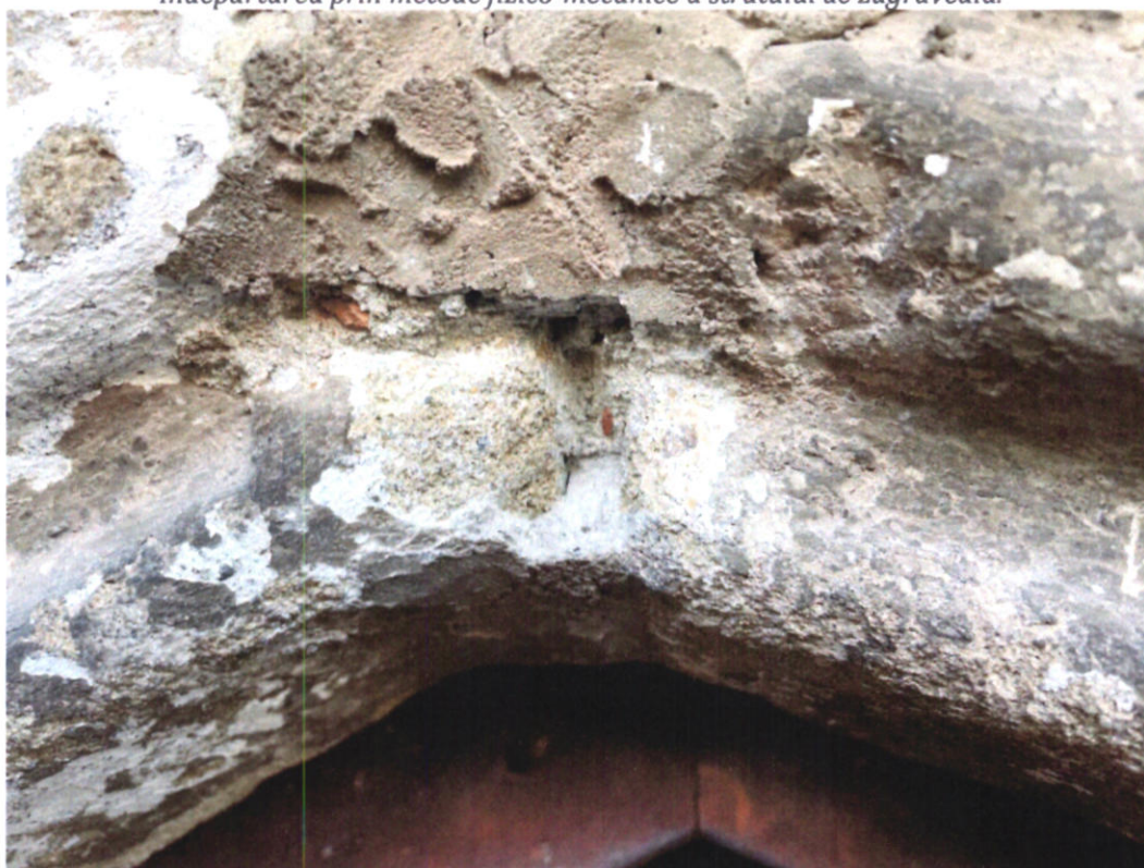
Rezultat final al testului de îndepărtare mortare și zugrăveli de intervenții.
