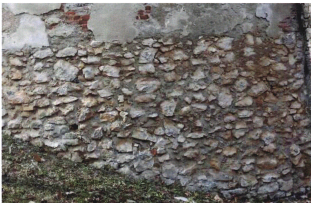
La baza bastionului este vizibil sistemul constructiv al zidăriei din bucăți de piatră nefasonate și cărămidă prinse în mortar de var. Este posibil ca această zonă să fi fost lăsată intenționat netencuită la ultima campanie de intervenții din 1960-1961
