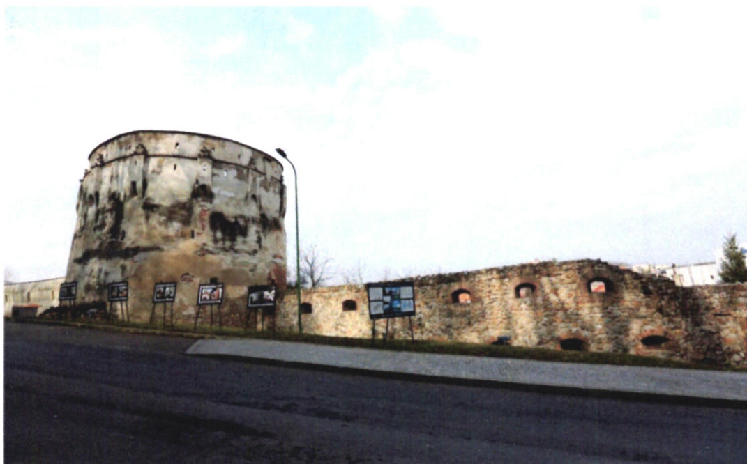
Turnul Postăvarilor și zidul de incintă vedere sud - est
