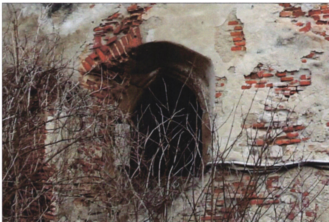
Detaliu al intrării de vest cu ancadramentul portalului din piatră (gresie)
