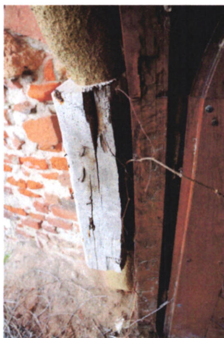
În partea dreaptă a portalului cadrul de lemn al ușii este prins în zidăria bastionului amplasat la o mică distanță de ansamblul litic.
