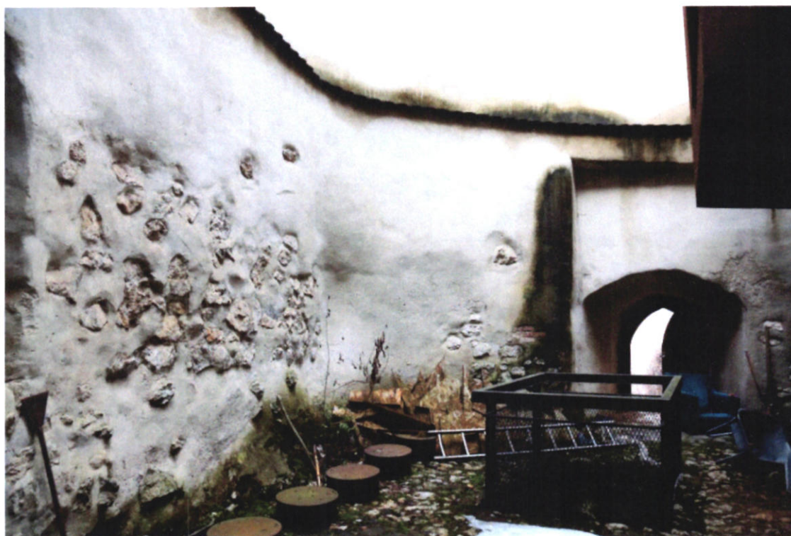
Curtea de la nivelul parterului cu deschiderea interioară a clădirii C I (cisternă), protejată cu o balustradă. Porțiuni ale blocurilor de piatră din zidărie au fost lăsate netencuite, (intervenții refacere tencuieli 2010), pentru a lăsa vizibil sistemul constructiv original.
