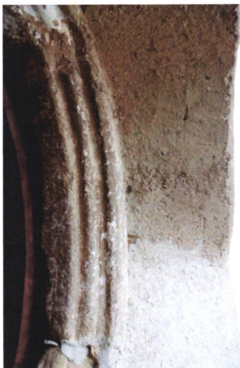
Detalii ale elementelor decorative din piatră ale portalului. Acesta este încadrat în zidăria de îmbinare a zidului bastionului cu zidului cetății. În partea superioară se mai păstrează profilatura pe rotund, în timp ce la nivelul inferior moloanele de piatră sunt puternic erodate și prinse cu bucăți de lemn.
