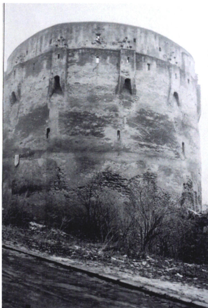
Vedere sud – arhiva DMSI 1992
