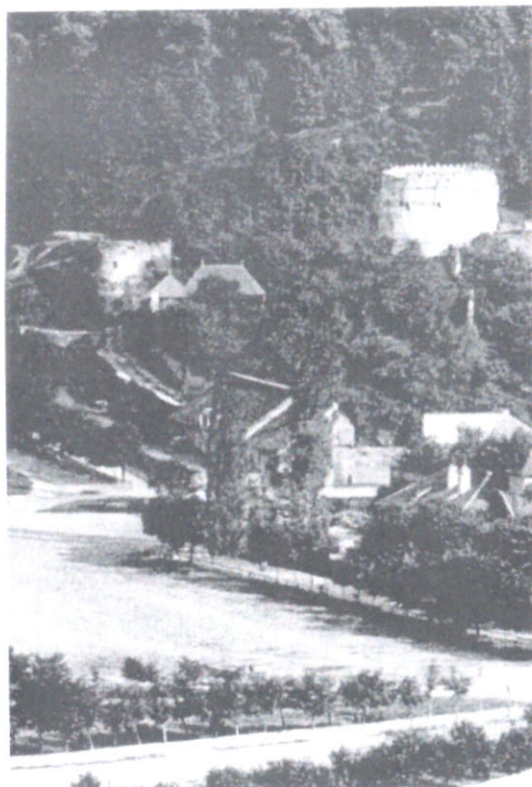
Fortificațiile de sud-est ale Cetății Brașovului la sfârșitul sec. al XIX-lea cu fragmente din zidurile de incintă, Bastionul Tăbăcarilor și Bastionul Postăvarilor cu coronamentul crenelat.
