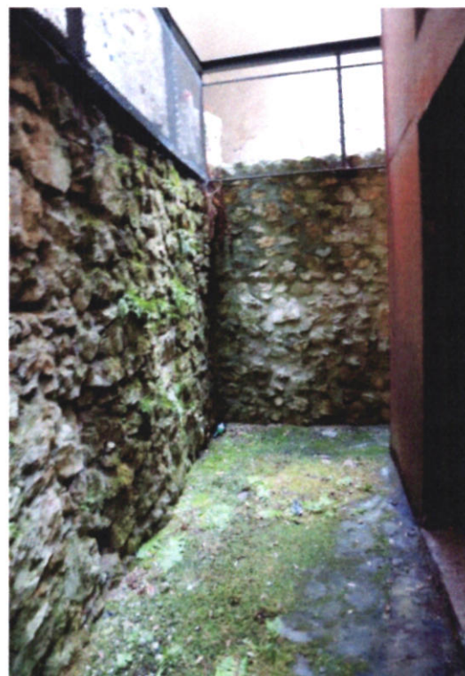
Pereții Clădirii C II – situați sub nivelul parterului. Pereții nu au fost tencuiți, doar au fost refăcute mortarele de rost ale zidăriei din blocuri de piatră.
