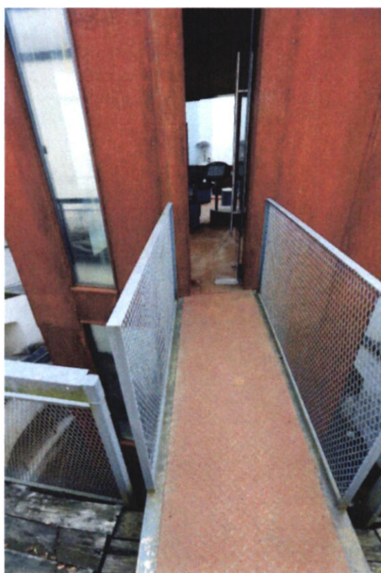
Pasarela ce face legătura dintre turnul interior și galeria circulară de-a lungul zidului din partea superioară.
