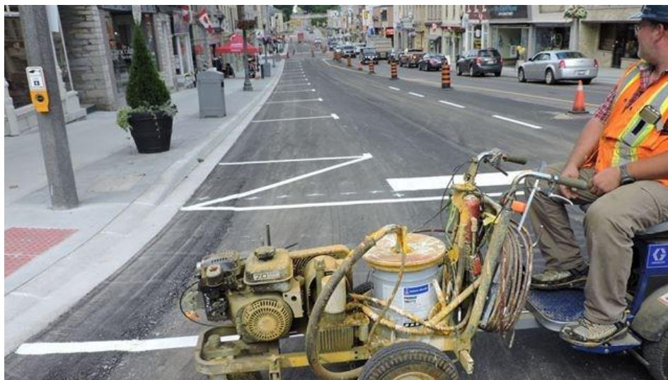
Fig. 5.2 : Trasarea marcajelor de delimitare a parcărilor
