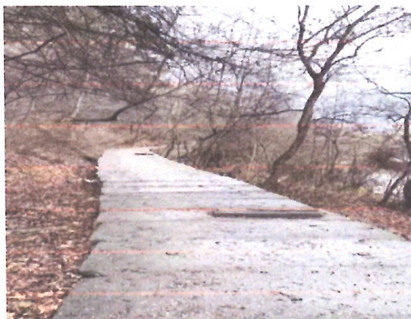
FOTO 5 Trotuar Canalul Timis
