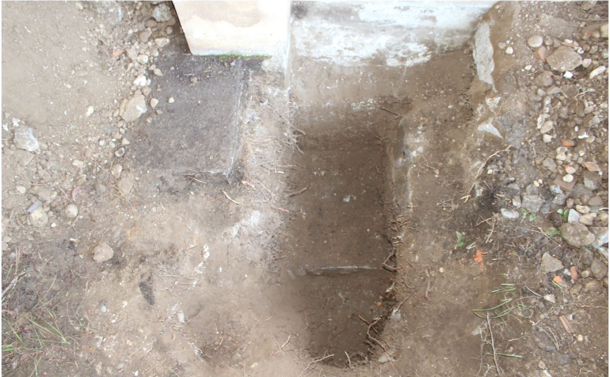
Foto 1 – Sondajul descopertă realizat
