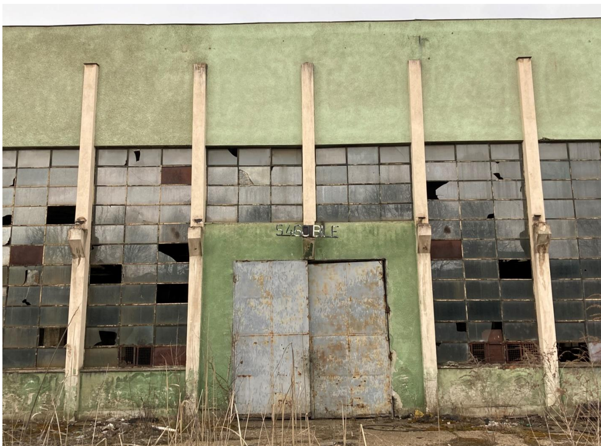
Hala secției strungărie (C25c). Detaliu de fațadă
