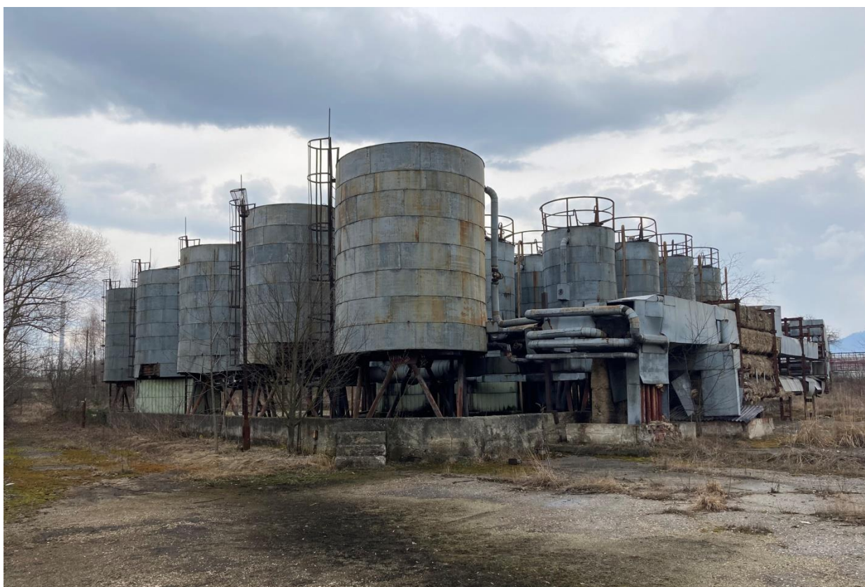
Depozitul de uleiuri (rezervoare metalice)
