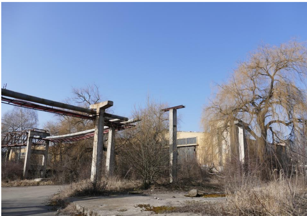
În zona centrală, vedere spre hangarul 4 (C13)
