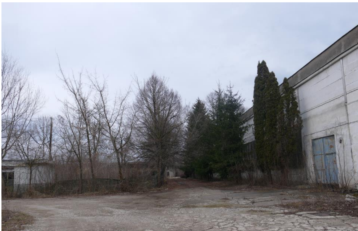
Spațiul cuprins între Corpul C7 și C4
