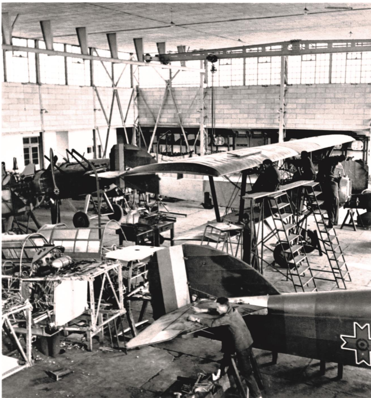
Fig. 13. Interiorul unui hangar (unde funcționa, probabil, unul dintre atelierele de montaj). Sunt vizibile elementele de structură verticale, modul de tratare a suprafețelor pline verticale și a plafonului și modul de luminare (bandă continuă de ferestre).
