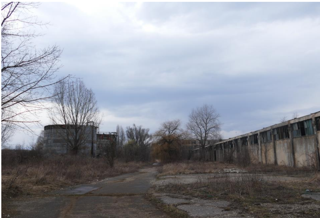
Magazia de oțeluri trase (C16) și rezervoarele gospodăriei de păcură
