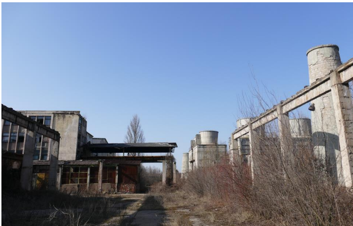
Aleea din spatele hangarelor în dreptul hangarului 6 (C15), de la SE la NV, cu vederea laturii posterioare a hangarului 5 (C14) și a turnurilor de răcire
