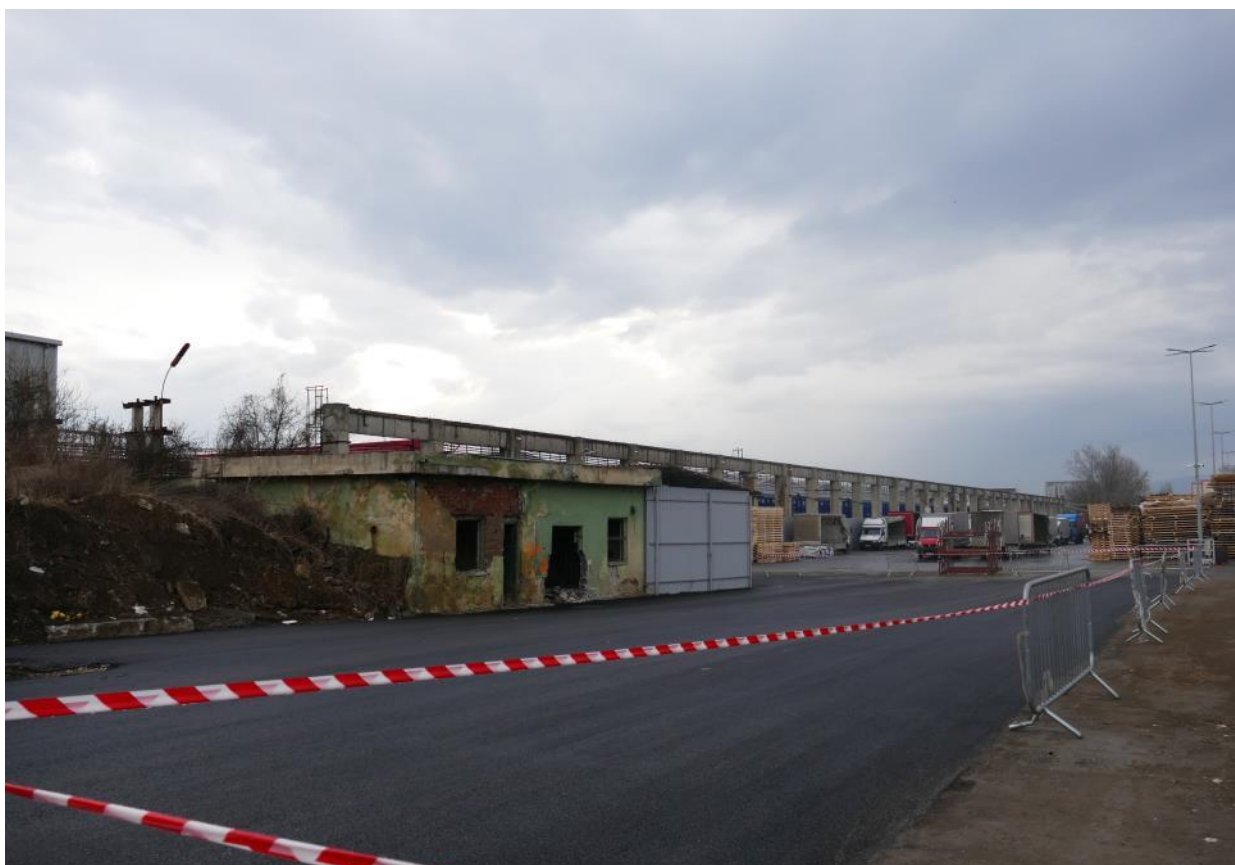
Accesul spre fosta hală a secției de cuzineți (C27), azi proprietate privată
