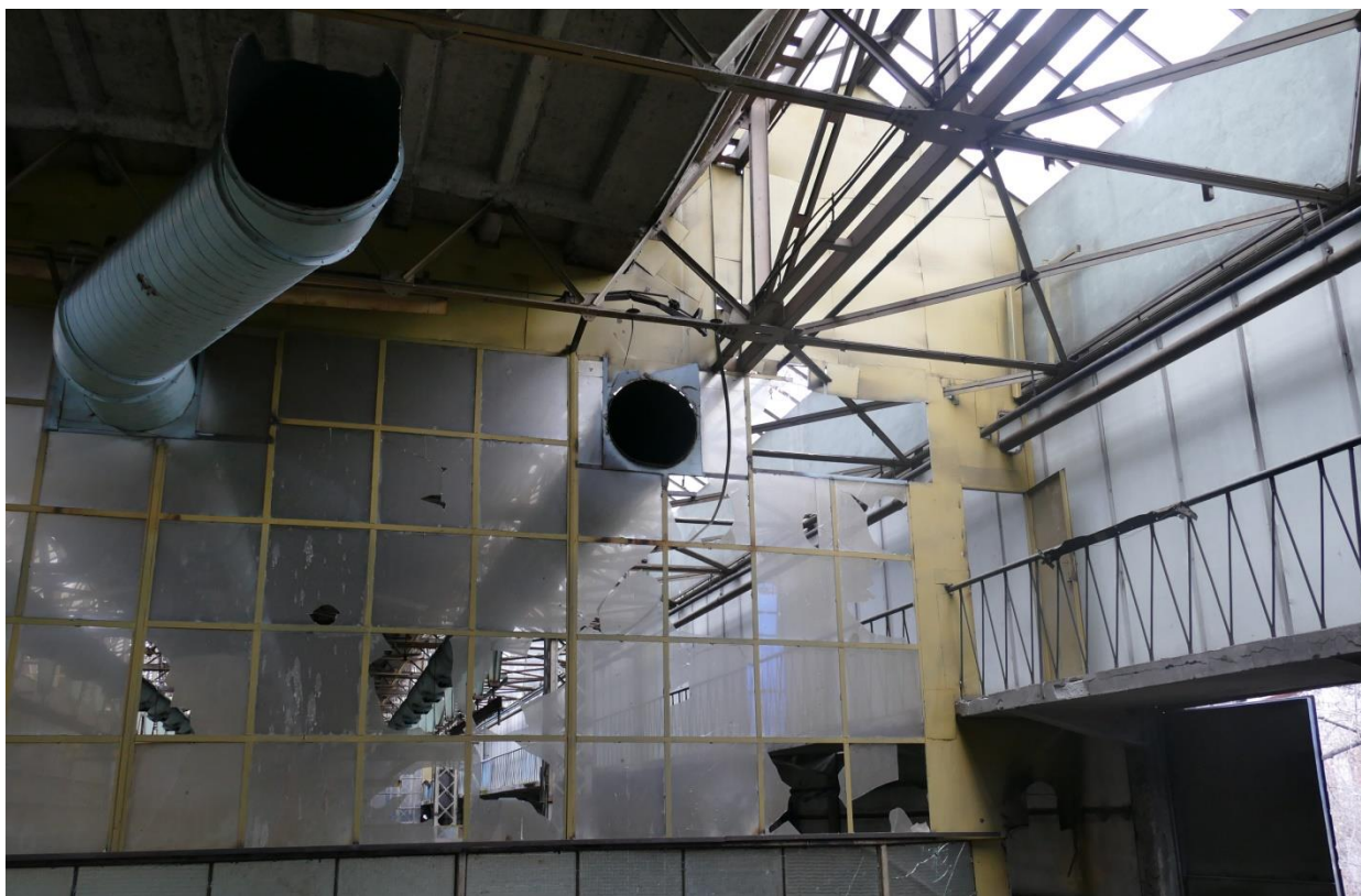
Secția de fabricație bile (C25b). Pasarelă pe latura de V
