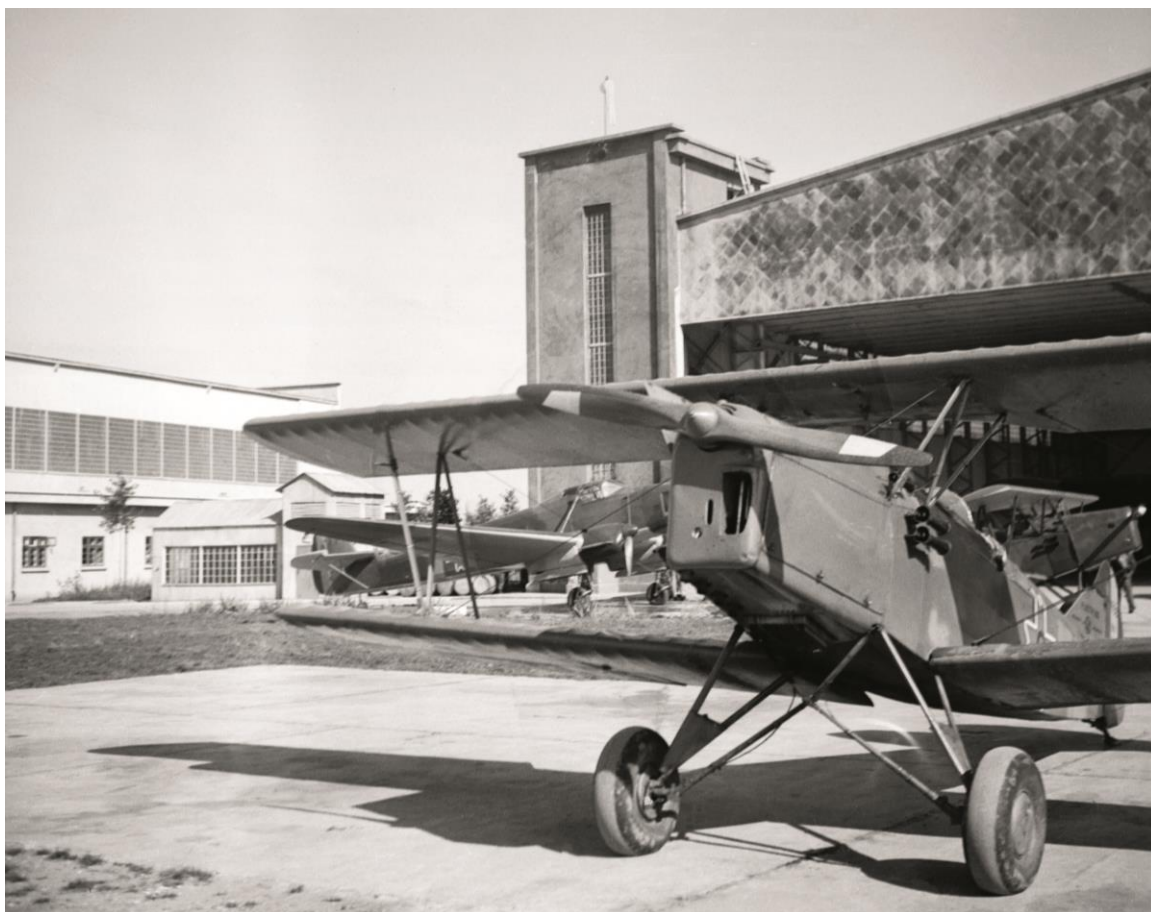
Fig. 9. Construcții pe amplasamentul Flotilei. În prim plan se vede pavajul din dreptul hangarelor; în plan secund, vegetația tânără, recent plantată, dintre hangare
