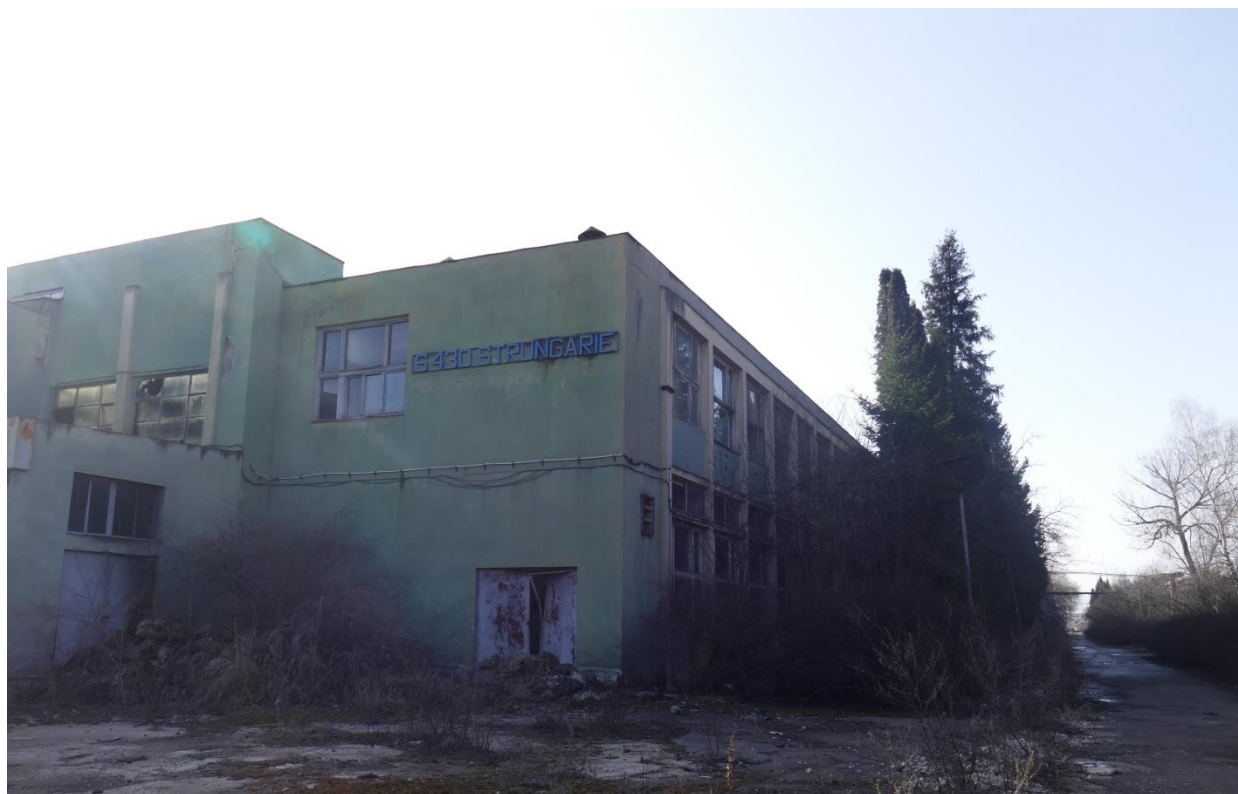
Hala secției strungărie (C25c). Colțul NE
