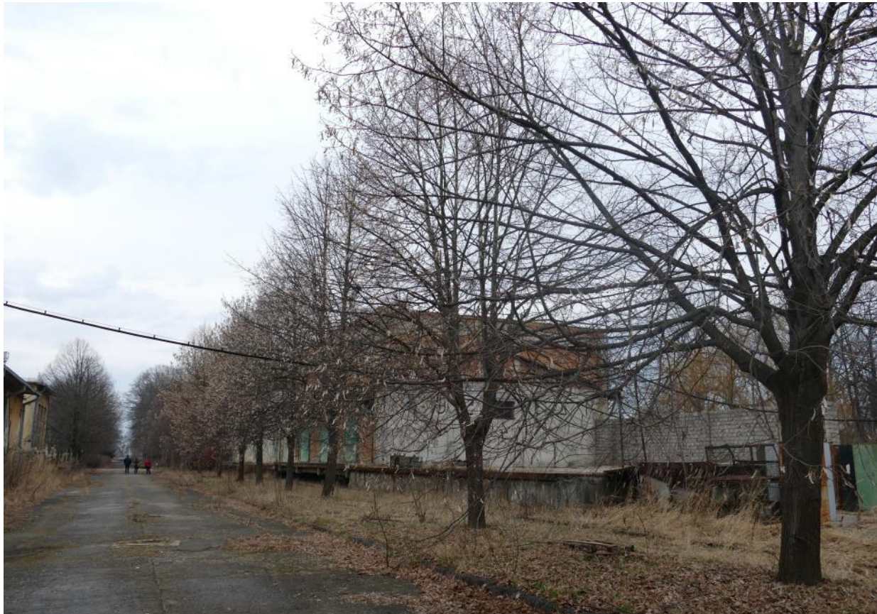
Fosta magazie centrală (C4) și linia de cale ferată din perioada interbelică
