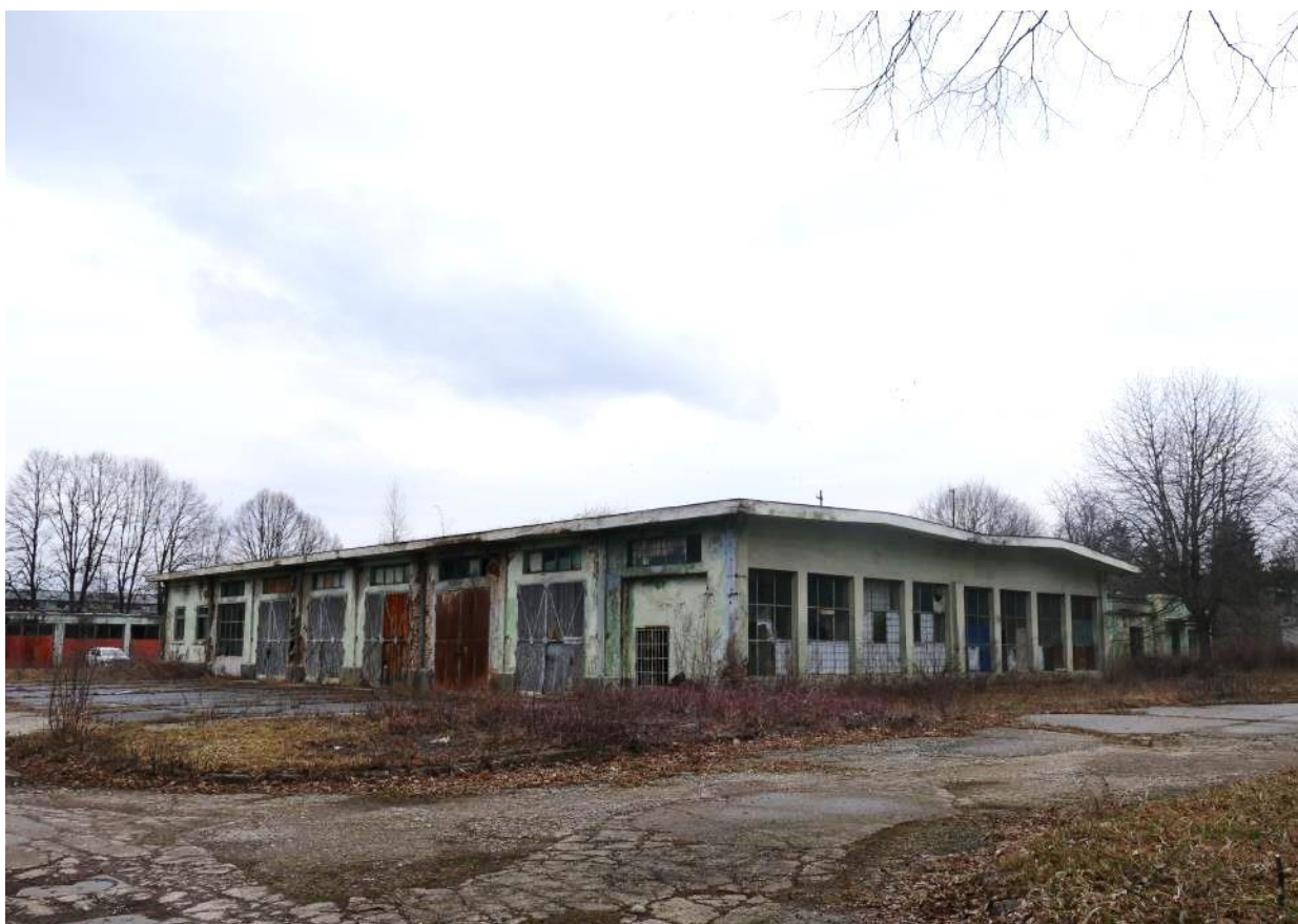
Corpul C5. Partea din față corespunde garajului Flotilei, construit în 1936
