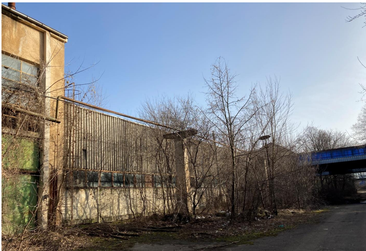
Fațada halei pentru secția TRM (C25d)
