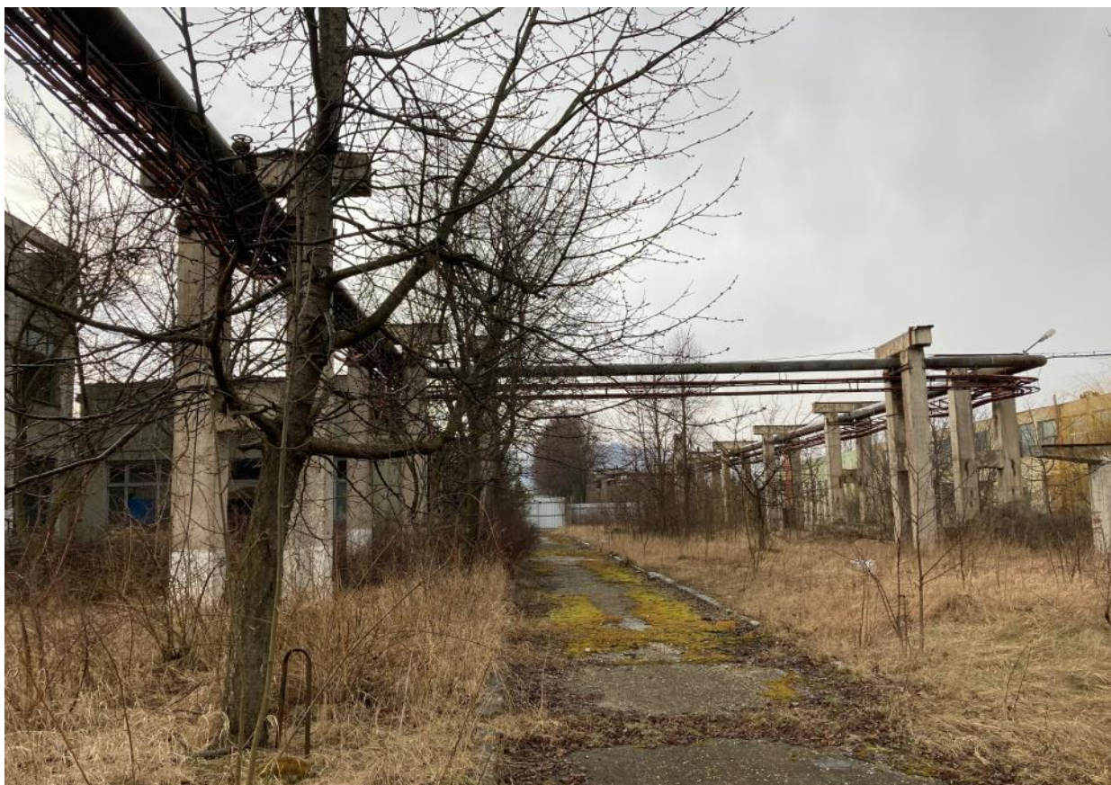
Aleea pe lângă centrala termică 3 (C26), de la N la S
