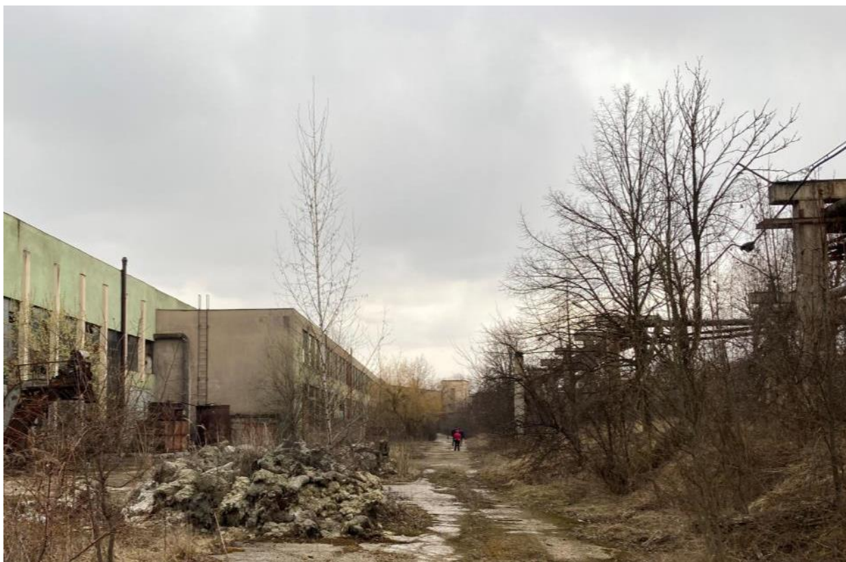
Aleea dintre secția strungărie (C25c) și centrala termică 3 (C26), de la S spre N
