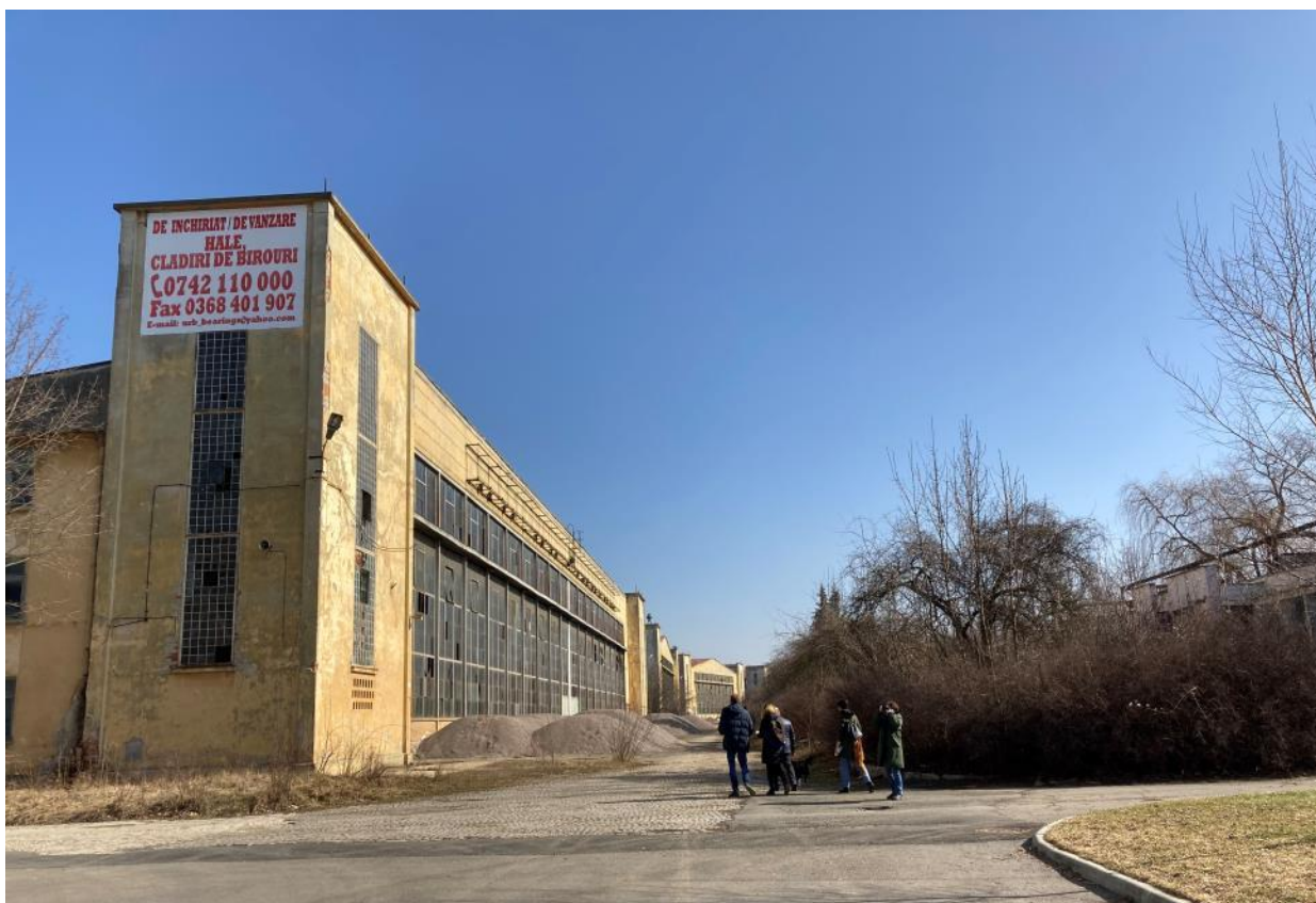
Hangarul 2 (C11), cu vederea hangarelor 3 (C12) și 4 (C13) în fundal, de pe aleea din fața hangarelor, de la V la E
