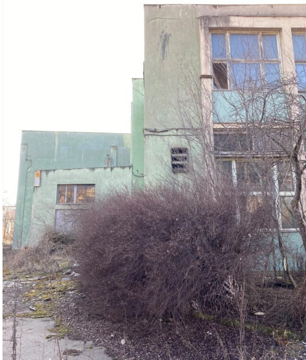
Hala secției strungărie (C25c). Colțul NE
