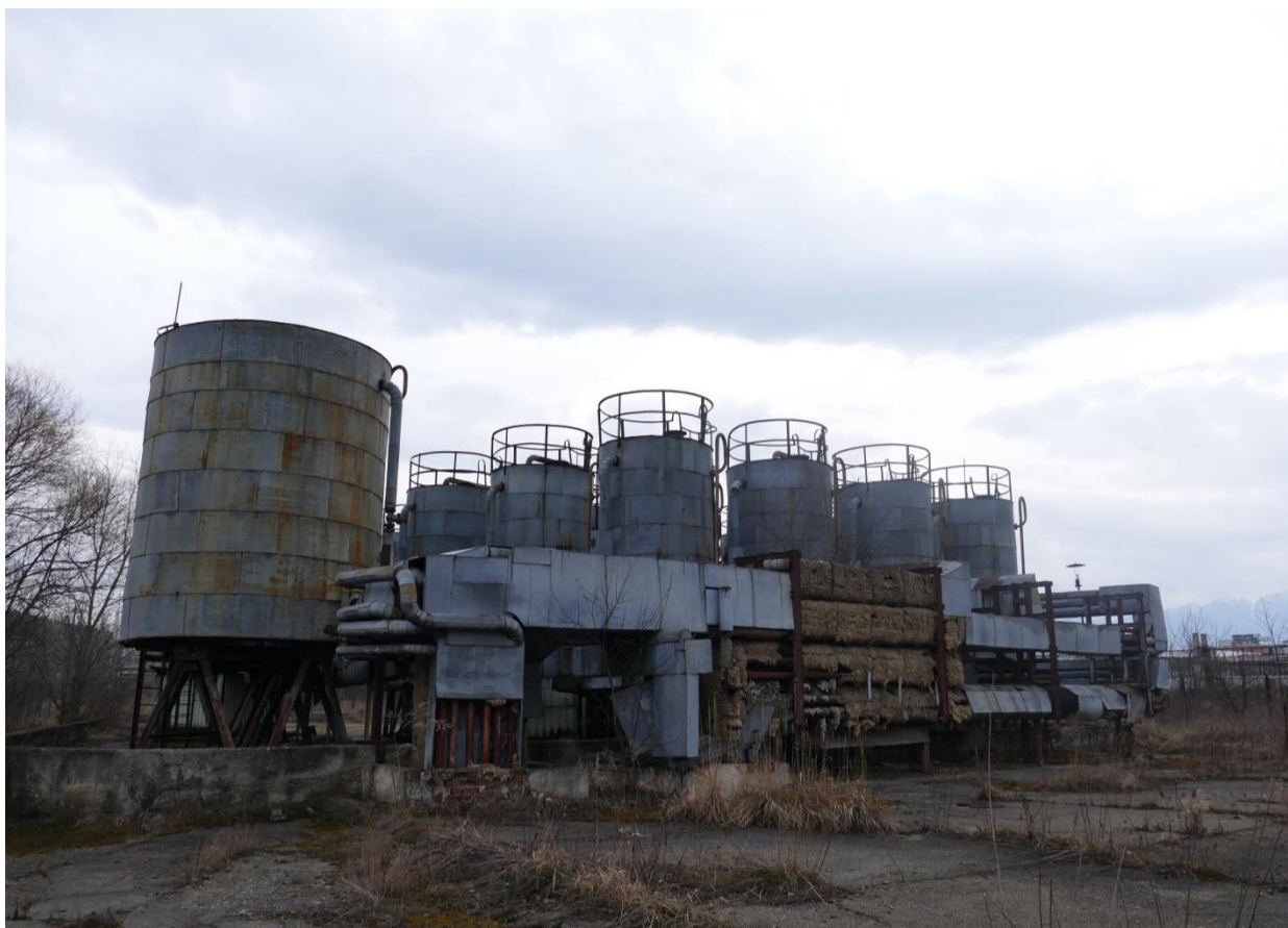
Depozitul de uleiuri (rezervoare metalice)
