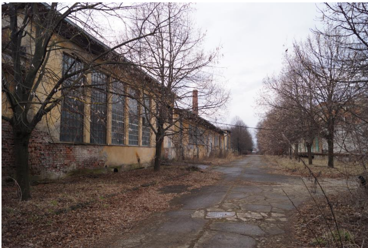
Aleea din spatele hangarelor în dreptul hangarului 2 (C11), de la E la V
