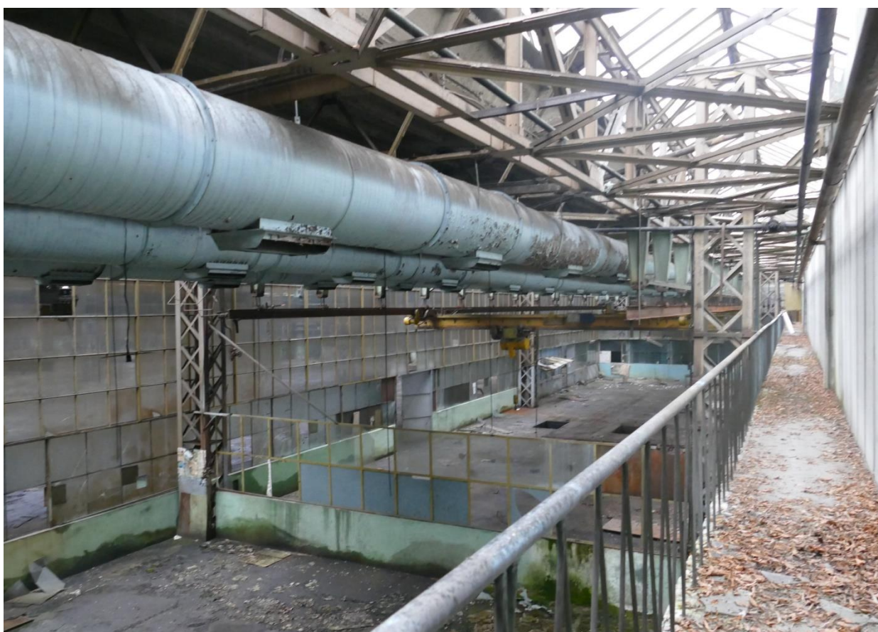
Secția de fabricație bile (C25b). Pasarelă pe latura de V
