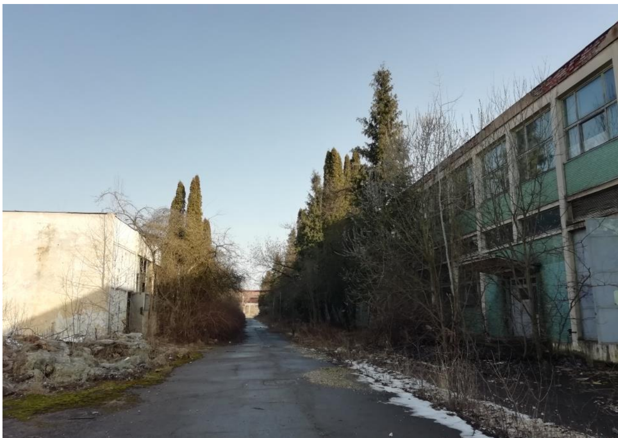
Alea centrală, în fața anexei tehnico-sociale de pe latura de N a halei mari (C15) de la V la E
