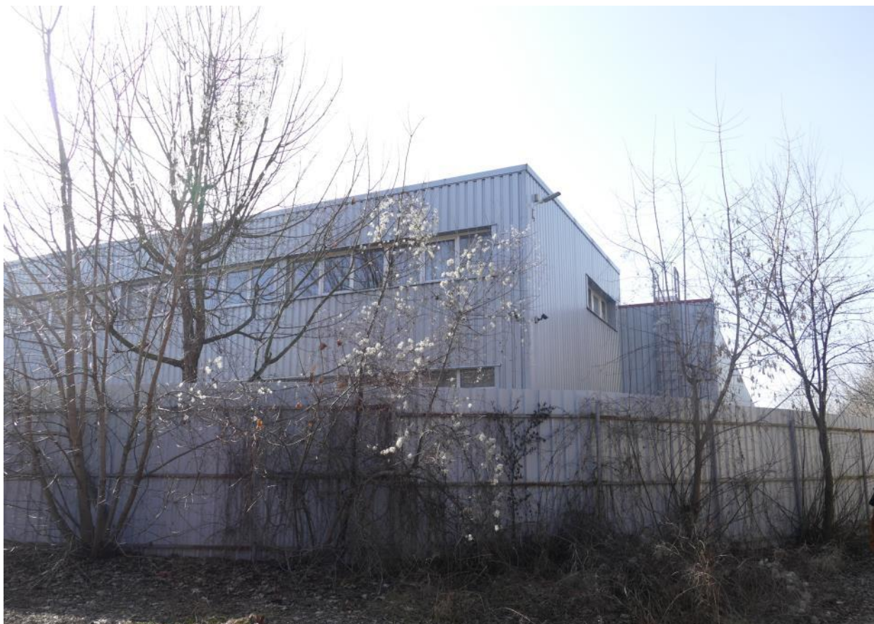
Fosta hală a secției de cuzineți (C27), azi proprietate privată
