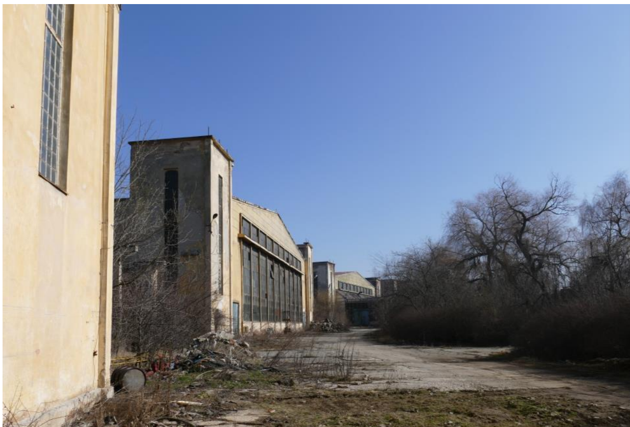
Hangarelor 4 (C13) și 5 (C14) de pe aleea din fața hangarelor, din dreptul hangarului 3 (C12), de la V la E
