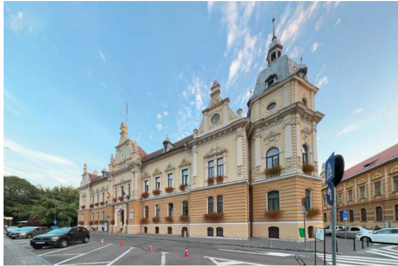
Primăria Brașov - existent ziua
