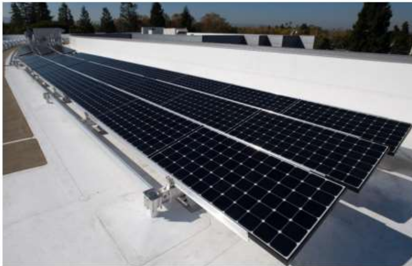
Fig. 2.4 – Module cu cate 72 celule fotovoltaice [21]
