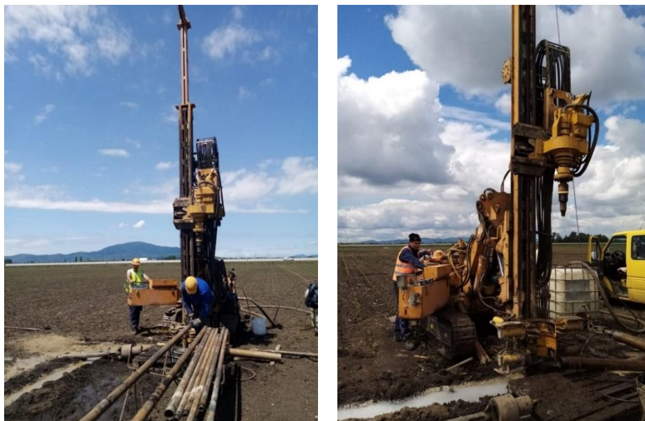
Figura 12. Fotografii din timpul execuției lucrărilor de teren
