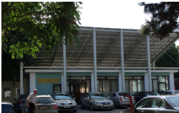
Figura 41 – Panou fotovoltaic pe cadire, care deservește un Centru de comandă funcțional (Primăria Municipiului Alexandria)
