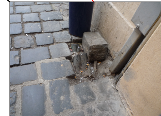
pavaj deteriorat
