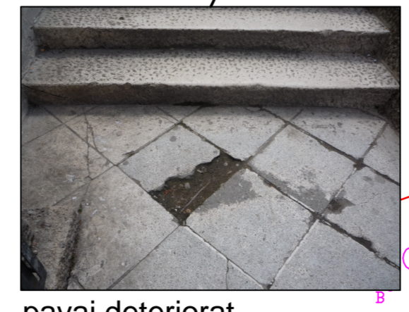
pavaj deteriorat
