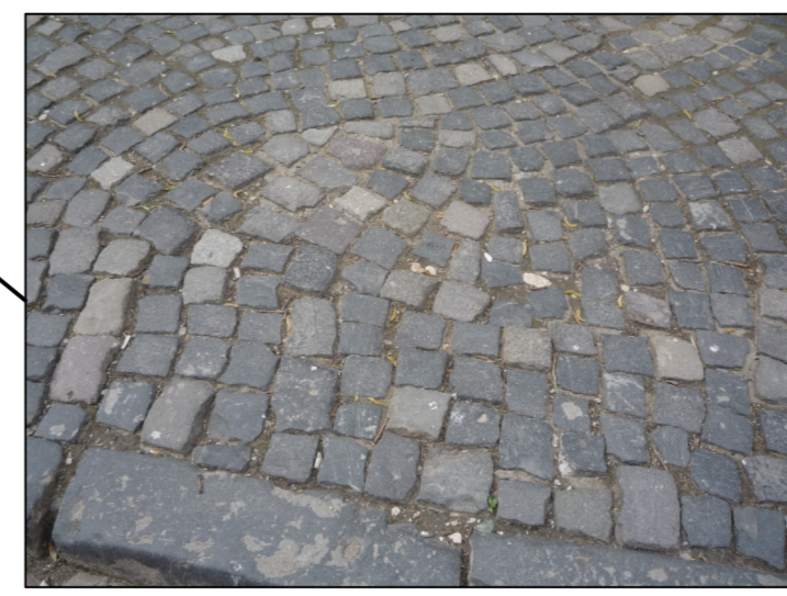
pavaj deteriorat
