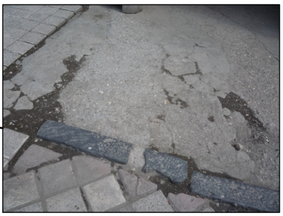
pavaj deteriorat
