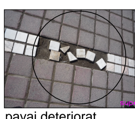
pavaj deteriorat
