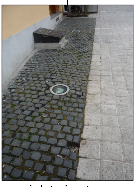
pavaj deteriorat
