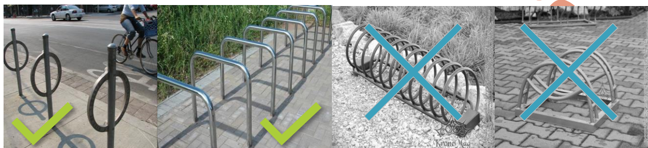
FIGURA 26 TIPURI DE RASTELE PENTRU BICICLETE SUGERATE ȘI MODELE NEINDICATE
