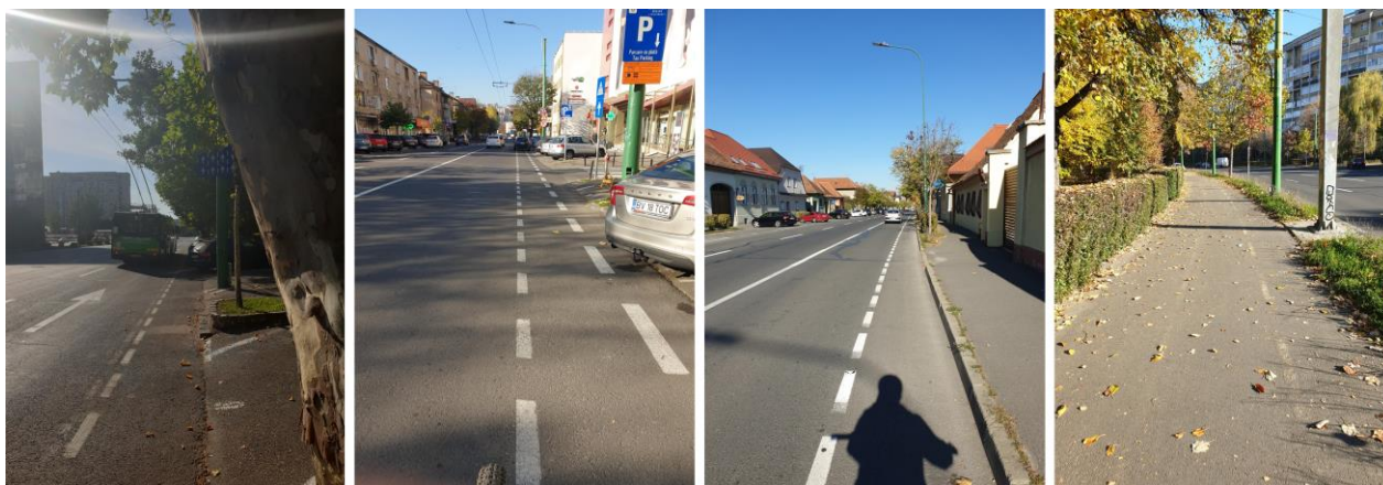
FIGURA 11 EXEMPLE DE BENZI / PISTE FĂRĂ MARCAJE CLARE SAU CU MARCAJE DETERIORATE
