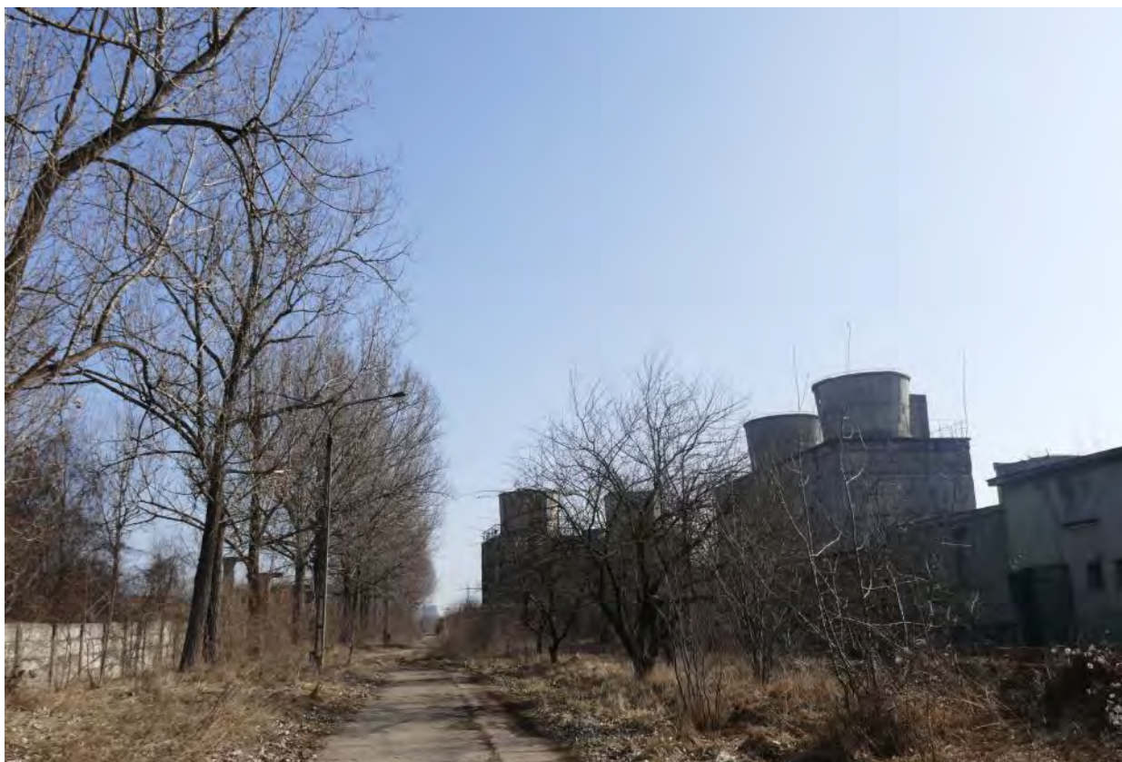
Aleea de pe limita de NE a proprietății, cu vederea turnurilor de răcire
