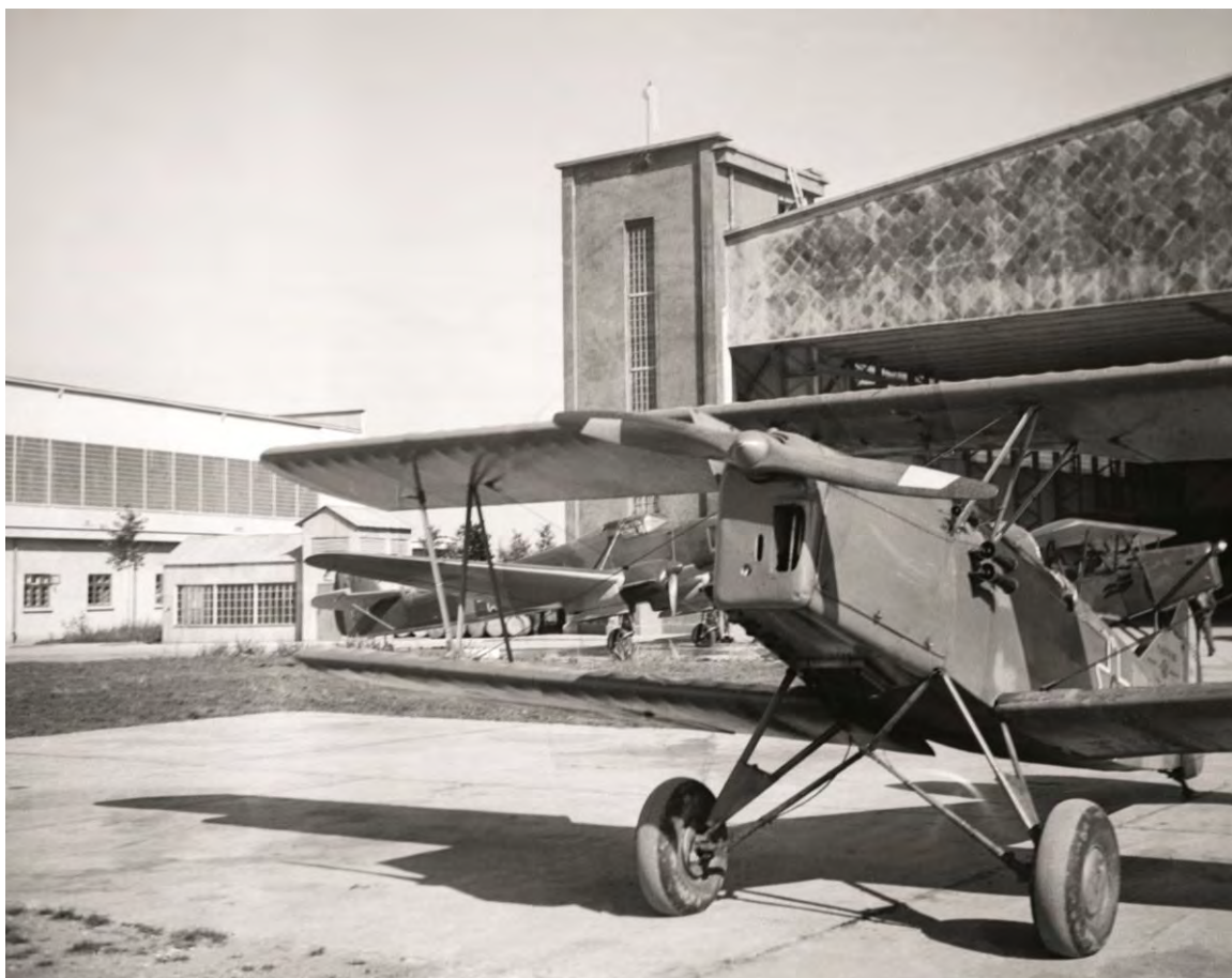
Fig. 9. Construcții pe amplasamentul Flotilei. În prim plan se vede pavajul din dreptul hangarelor; în plan secund, vegetația tânără, recent plantată, dintre hangare
