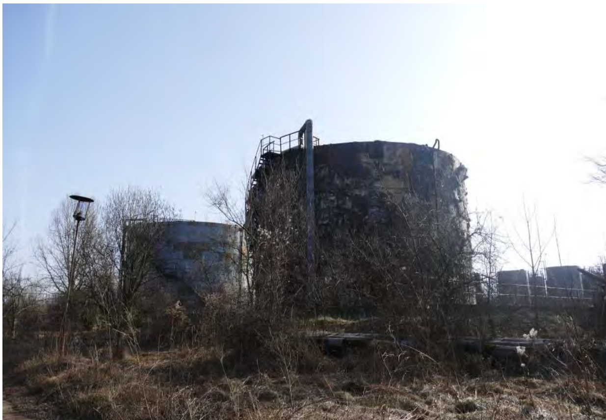
Rezervoarele gospodăriei de păcură
