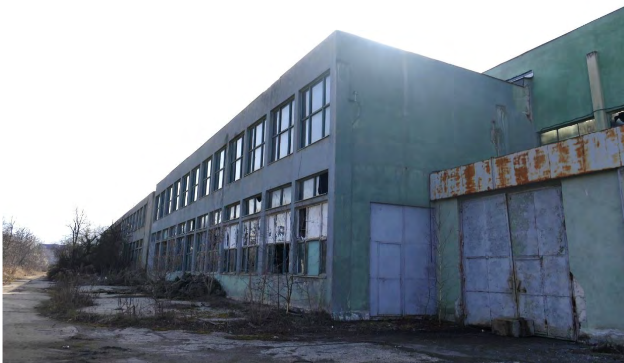
Hala secției strungărie (C25c). Latura E
