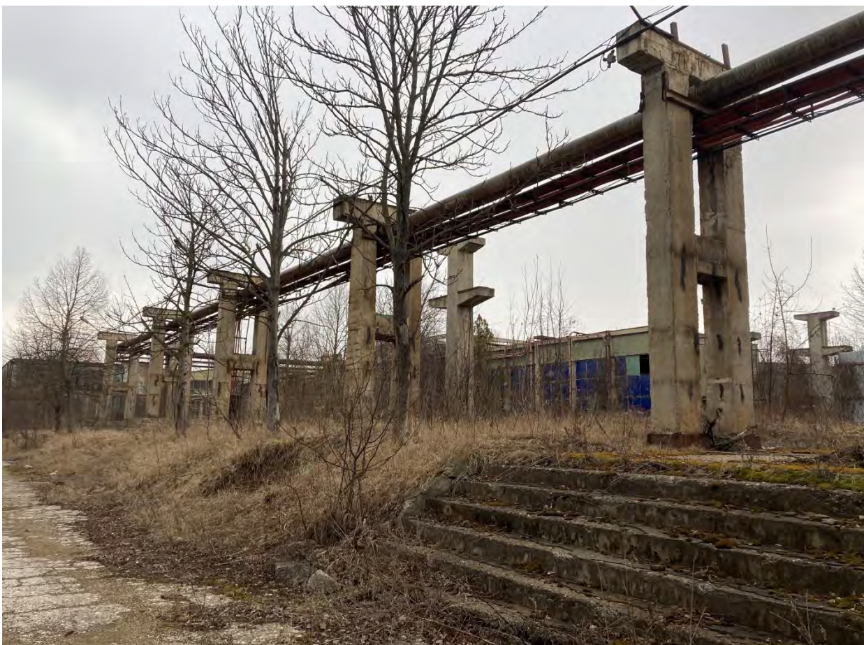
Între secția strungărie (C25c) și centrala termică 3 (C26)
