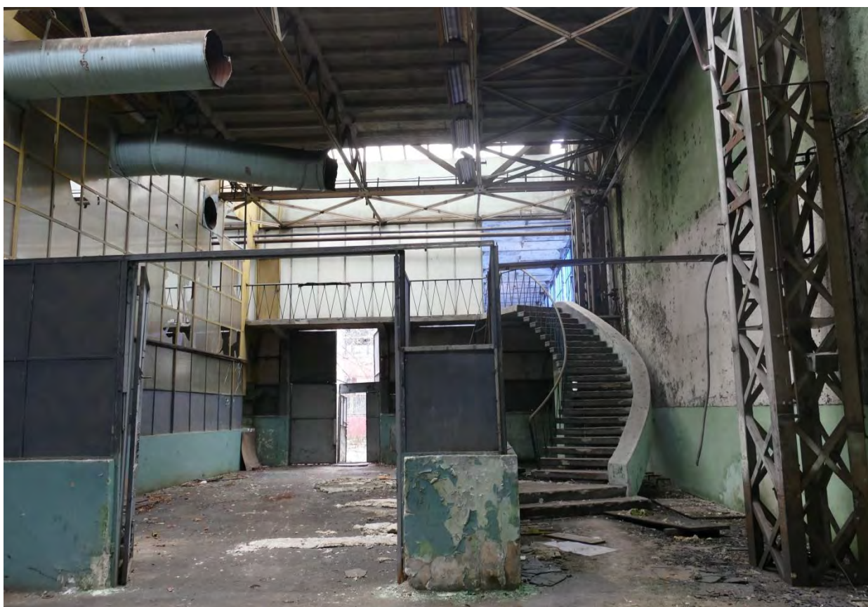
Secția de fabricație bile (C25b). Acces spre pasarela de legătură cu anexa tehnică (C24)
