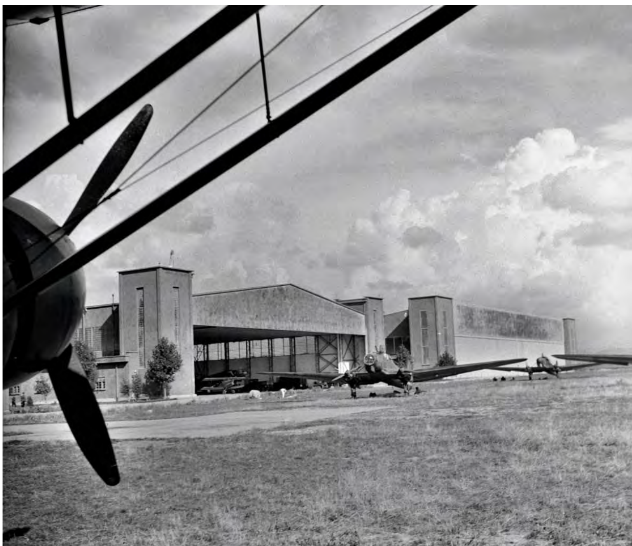
Fig. 8. Hangarele 5 și 6 ale Flotilei.
