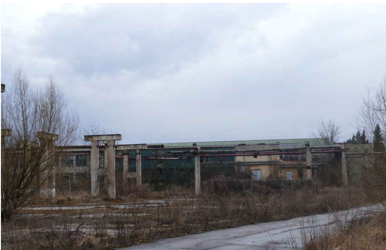
Între secția strungărie (C25c) și centrala termică 3 (C26)
