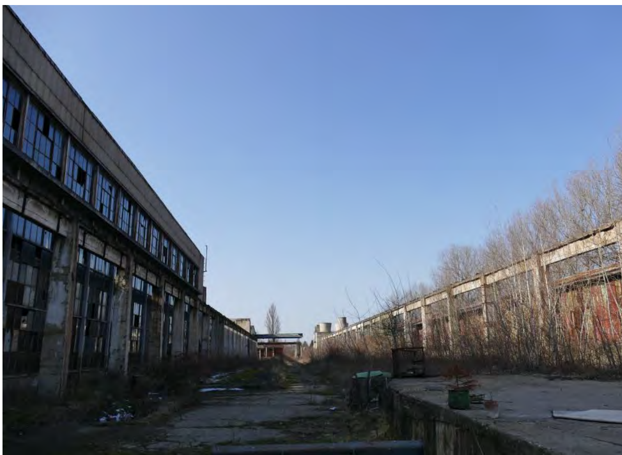
Aleea din spatele hangarelor în dreptul hangarului 6 (C15), spre NV
