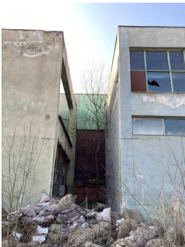
Hala secției strungărie (C25c). Detaliu (latura E)
