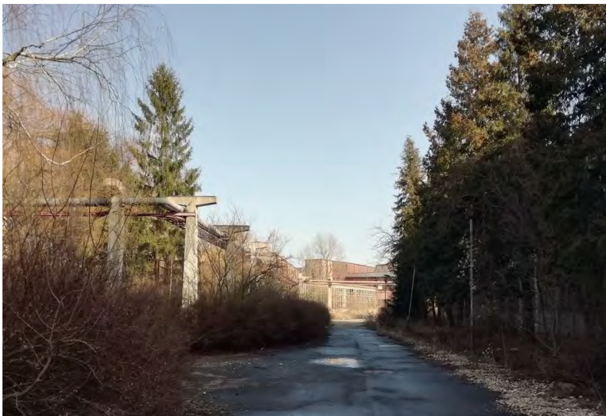
Aleea centrală, în fața anexei tehnico-sociale de pe latura de N a halei mari (C15) de la V la E
