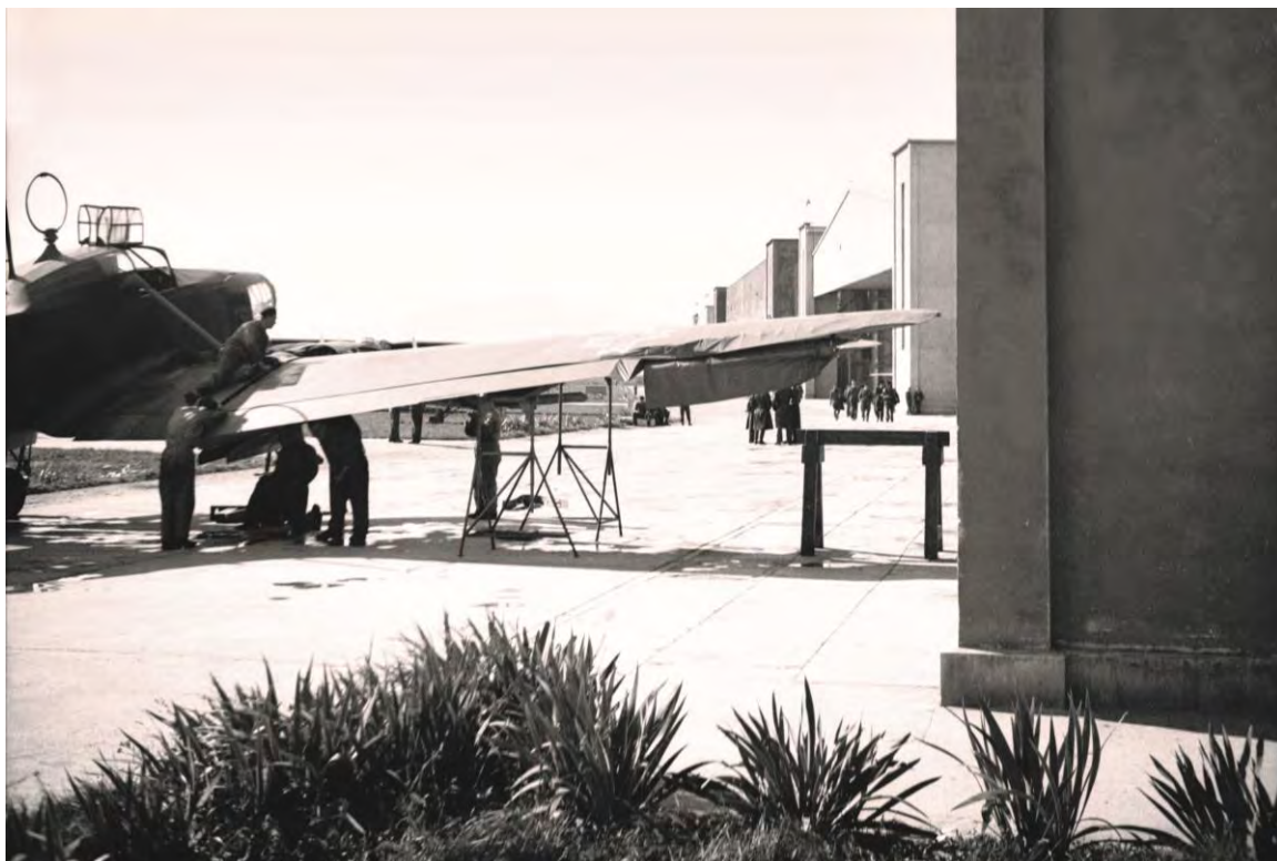
Fig. 10. Aleea din fața hangarelor
