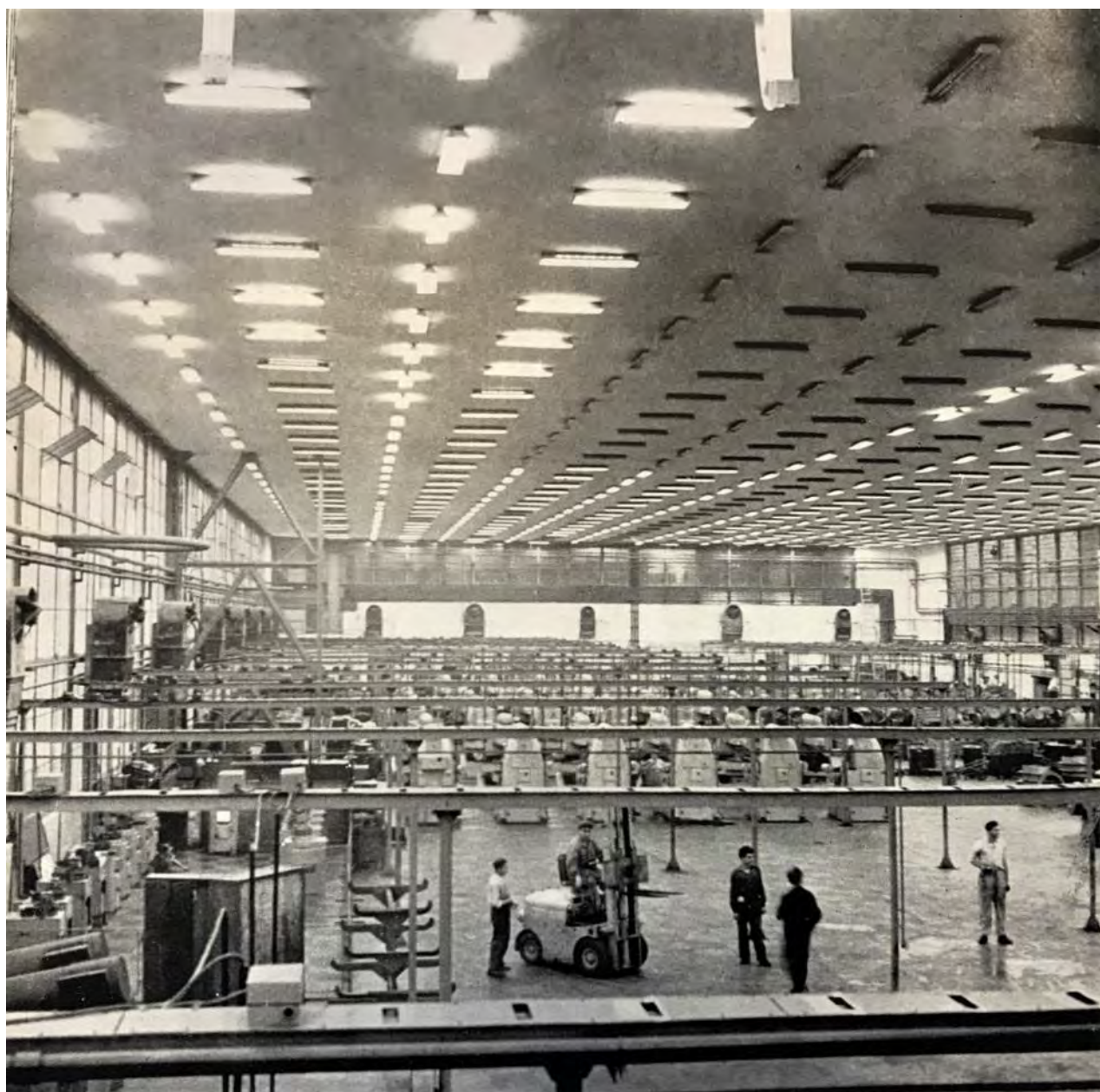
Fig. 15. Hangar transformat în hală de producție. Peretele din stânga corespunde laturii principale (vitraj amplu, care închide deschiderile de pe latura orientată spre fostul aerodrom, la origine prevăzute cu portiere mobile).
