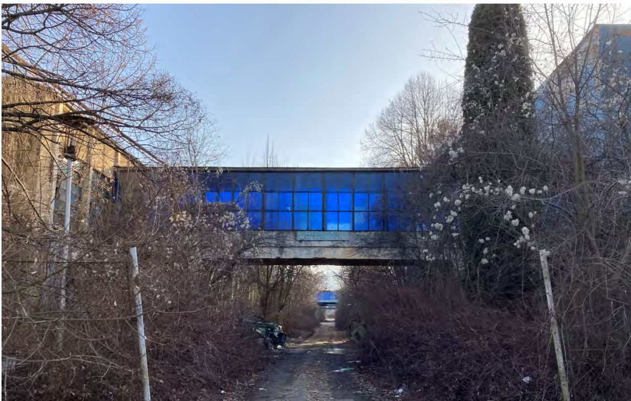
Drum uzinal la V de hala mare (C25), cu vederea pasarelelor de legătură a halelor (C25a și C25b) cu laboratorul uzinal (C21) și anexa tehnică (C24)
