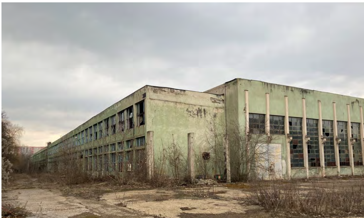
Anexa tehnico-socială (C25b) și hala secției strungărie (C25c)
