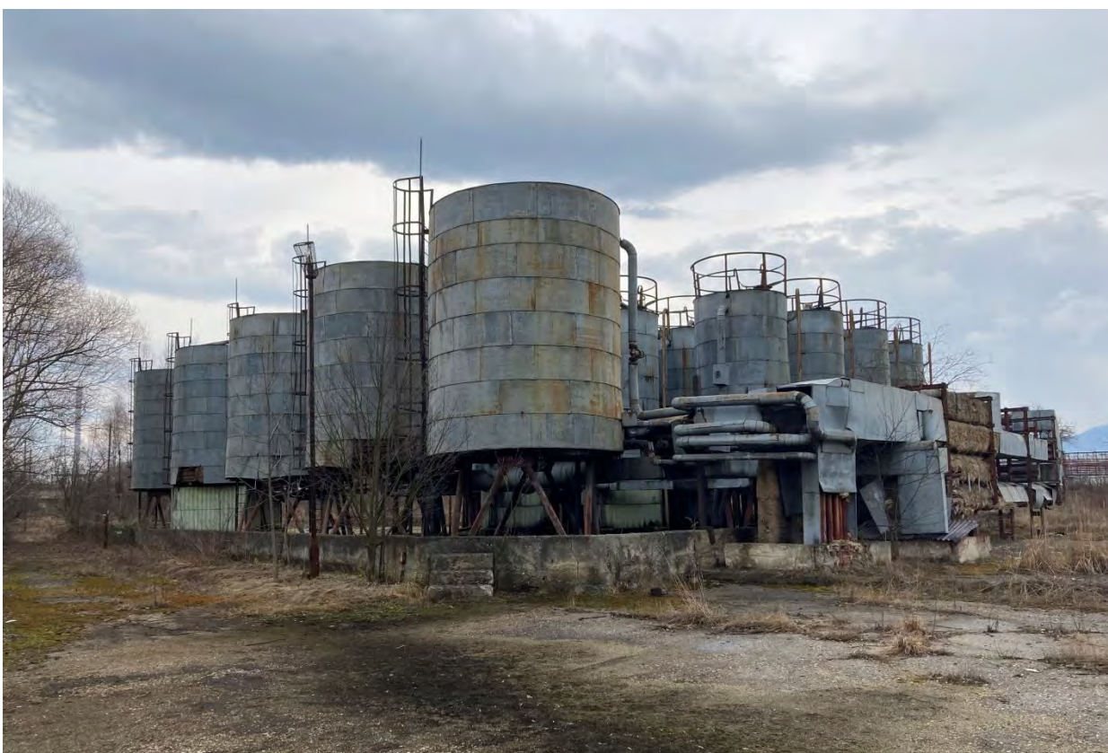
Depozitul de uleiuri (rezervoare metalice)
