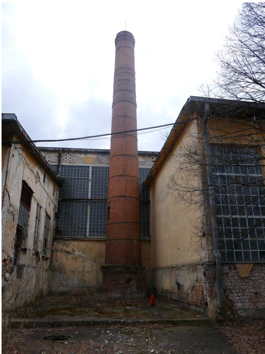
Coșul centralei termice de pe latura posterioară a hangarului 1
