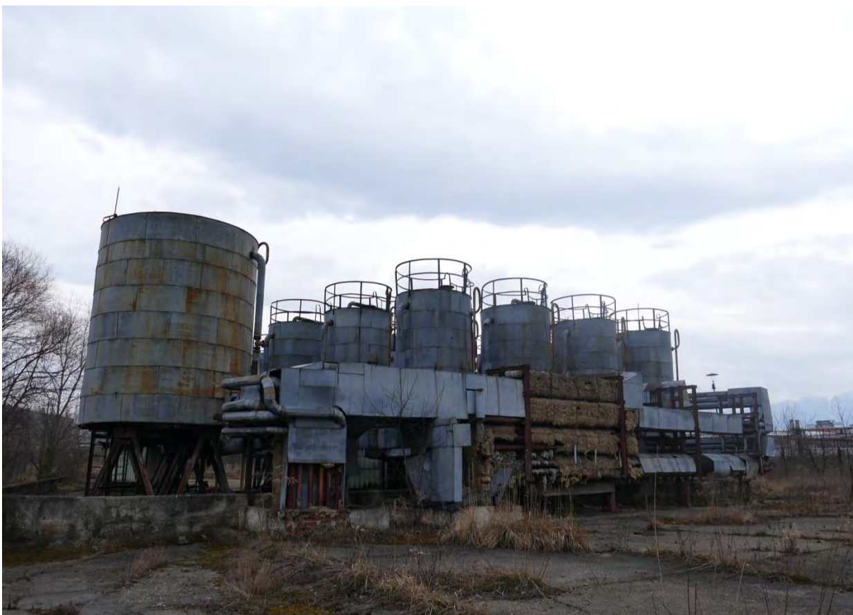
Depozitul de uleiuri (rezervoare metalice)
