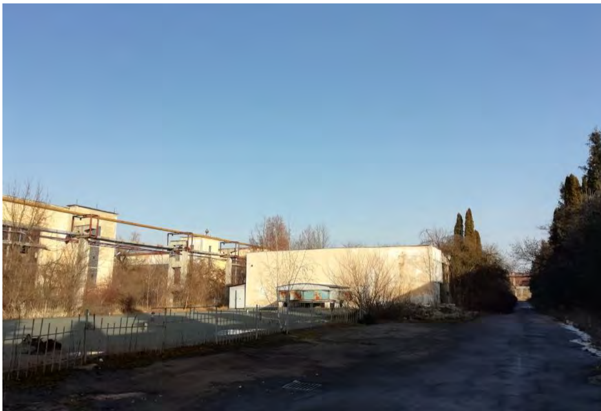
Alea centrală, în fața anexei tehnico-sociale de pe latura de N a halei mari (C15) cu vederea parțială a hangarelor 2 (C11) și 3 (C12), în fundal
