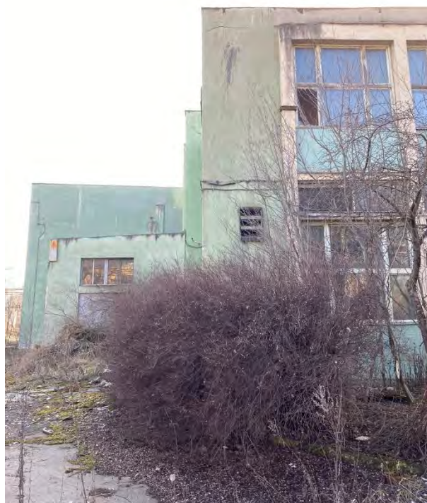
Hala secției strungărie (C25c). Colțul NE
