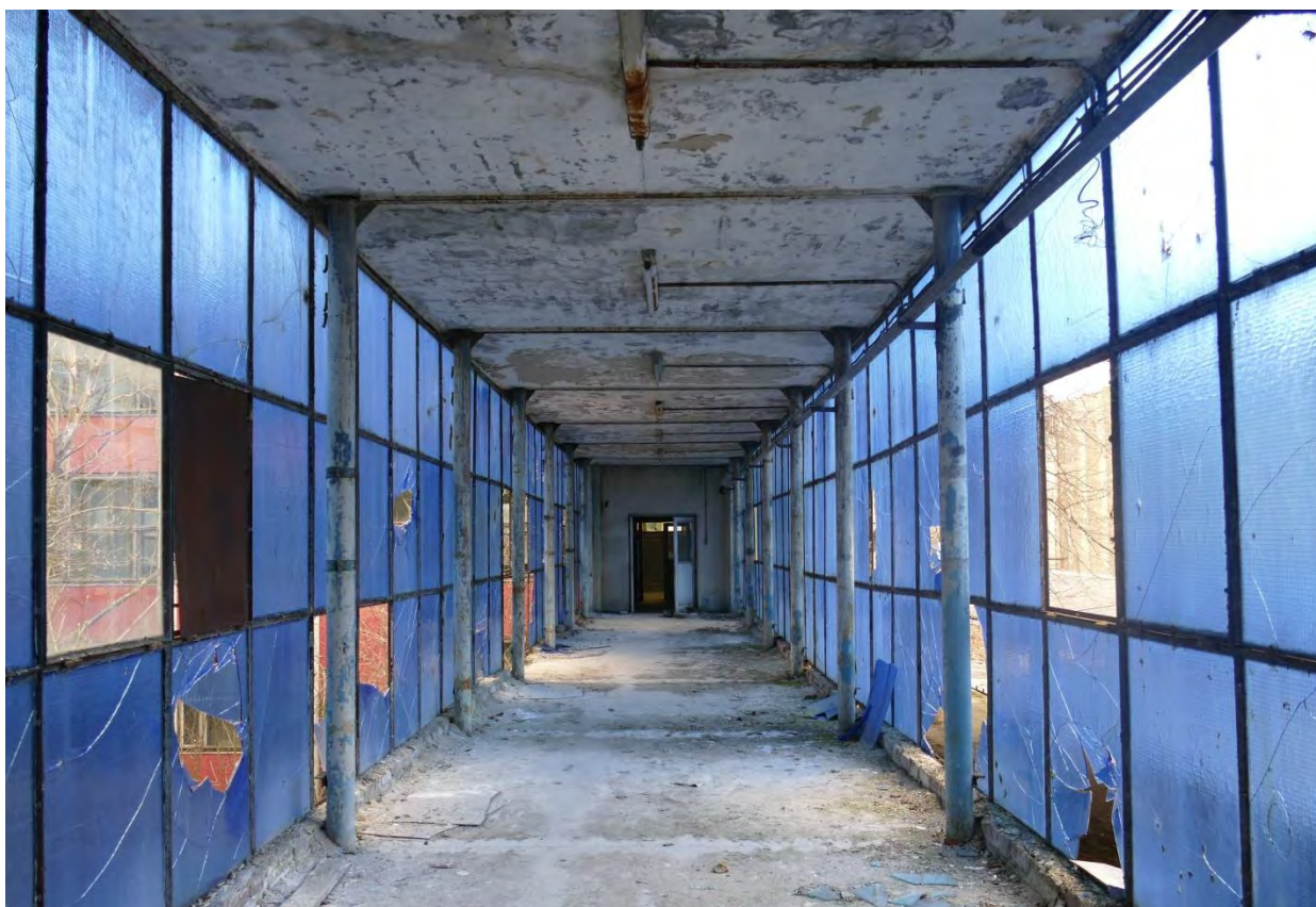
Pasarela de legătură între secția de fabricație bile (C25b) și anexa tehnică (C24)
