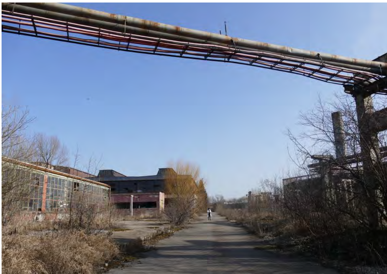
Adaosurile C14b și C15c văzute de pe aleea centrală, de la V spre E
