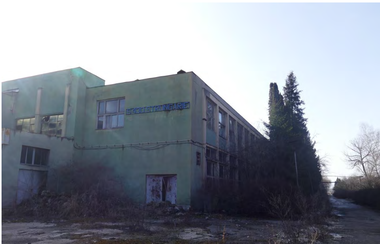
Hala secției strungărie (C25c). Colțul NE
