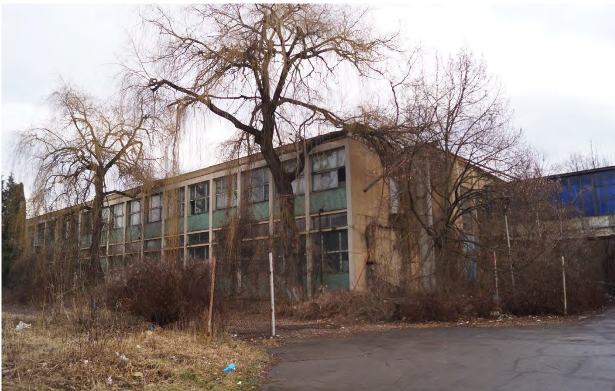
Anexa tehnico-socială (C25a) și pasarela de legătură cu laboratorul uzinal (C21)
