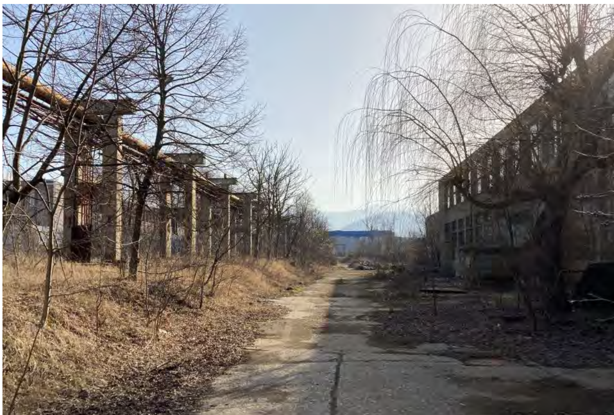
Aleea dintre secția strungărie (C25c) și centrala termică 3 (C26), de la N spre S
