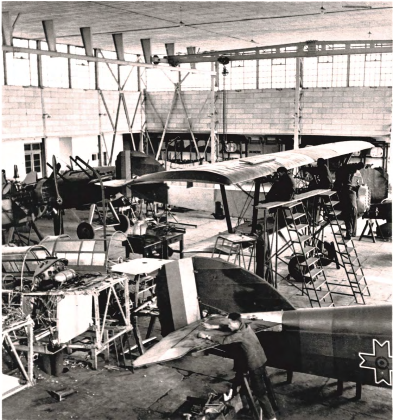
Fig. 13. Interiorul unuia dintre hangare (unde funcționa, probabil, unul dintre atelierelor de montaj). Sunt vizibile elementele de structură verticale, modul de tratare a suprafețelor pline verticale și a plafonului și modul de luminare (bandă continuă de ferestre).
