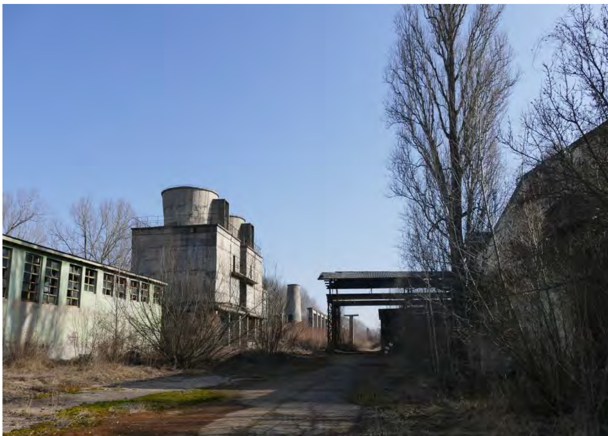
Aleea din spatele hangarelor în dreptul hangarelor 4 (C13) și 5 (C14), de la NV la SE
