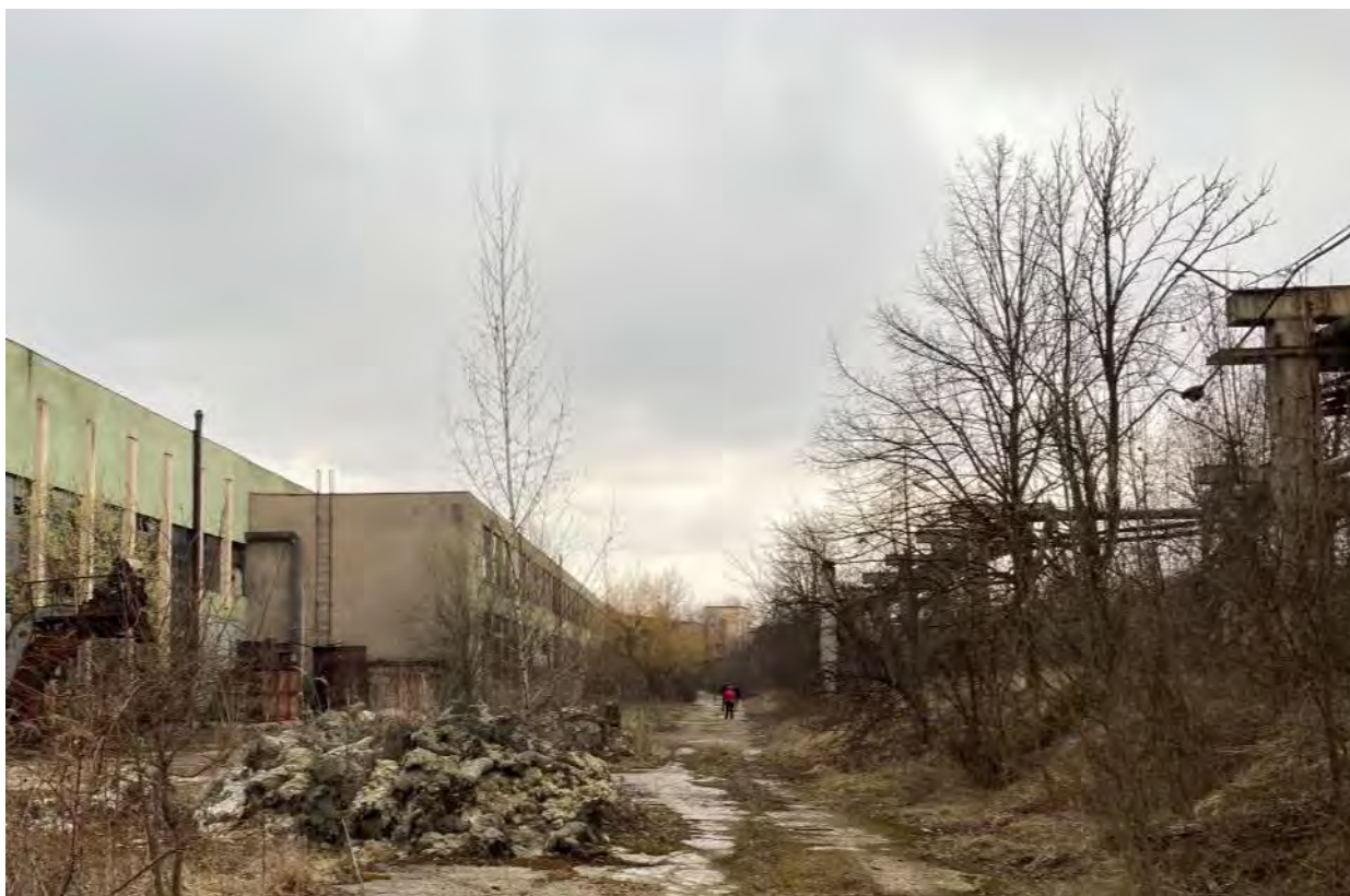
Aleea dintre secția strungărie (C25c) și centrala termică 3 (C26), de la S spre N
