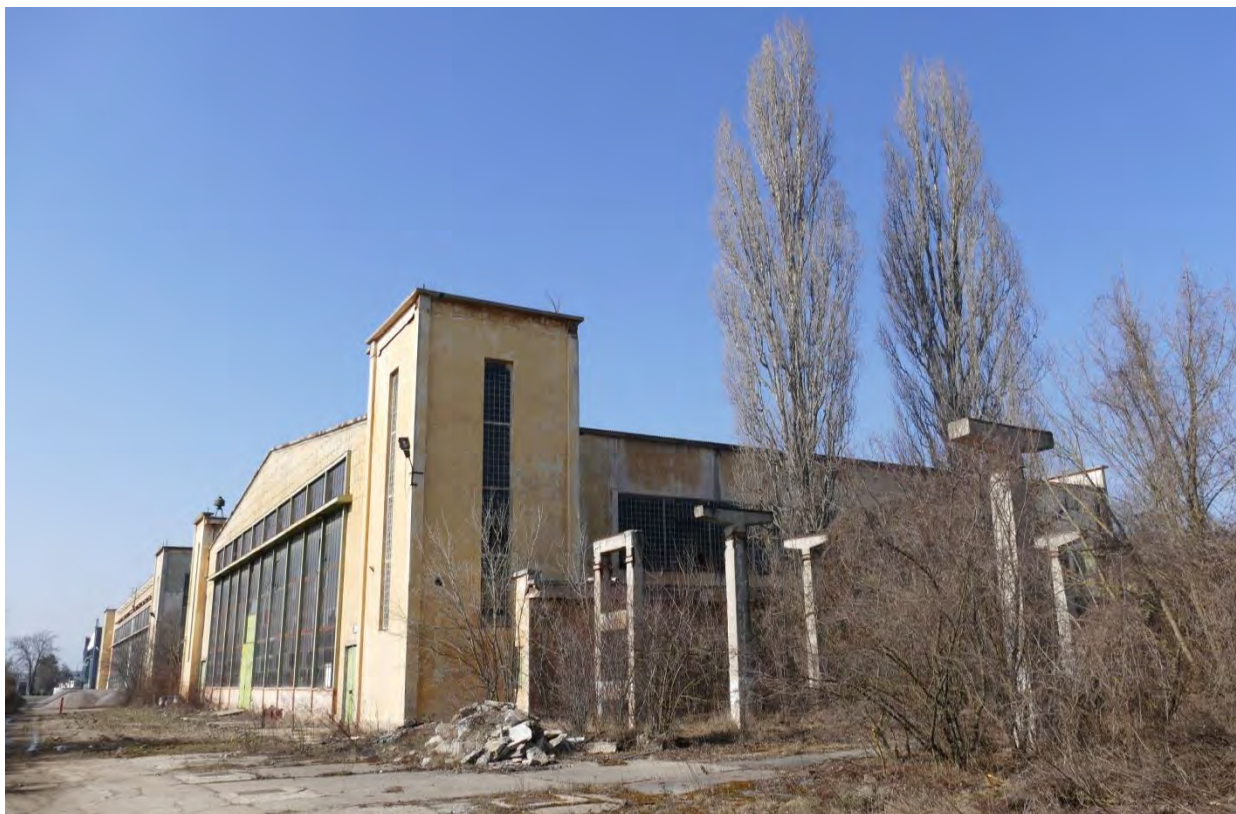
Între hangarele 3 și 4
