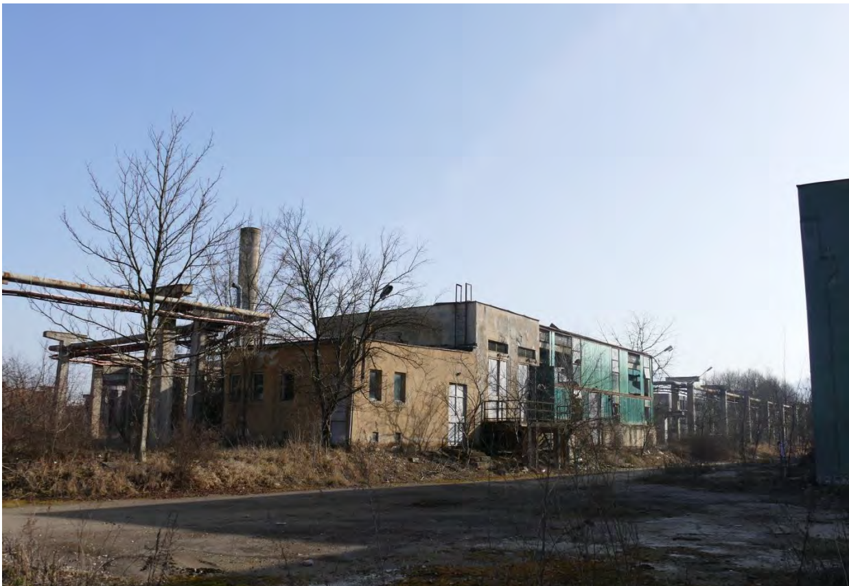
Între secția strungărie (C25c) și centrala termică 3 (C26)
