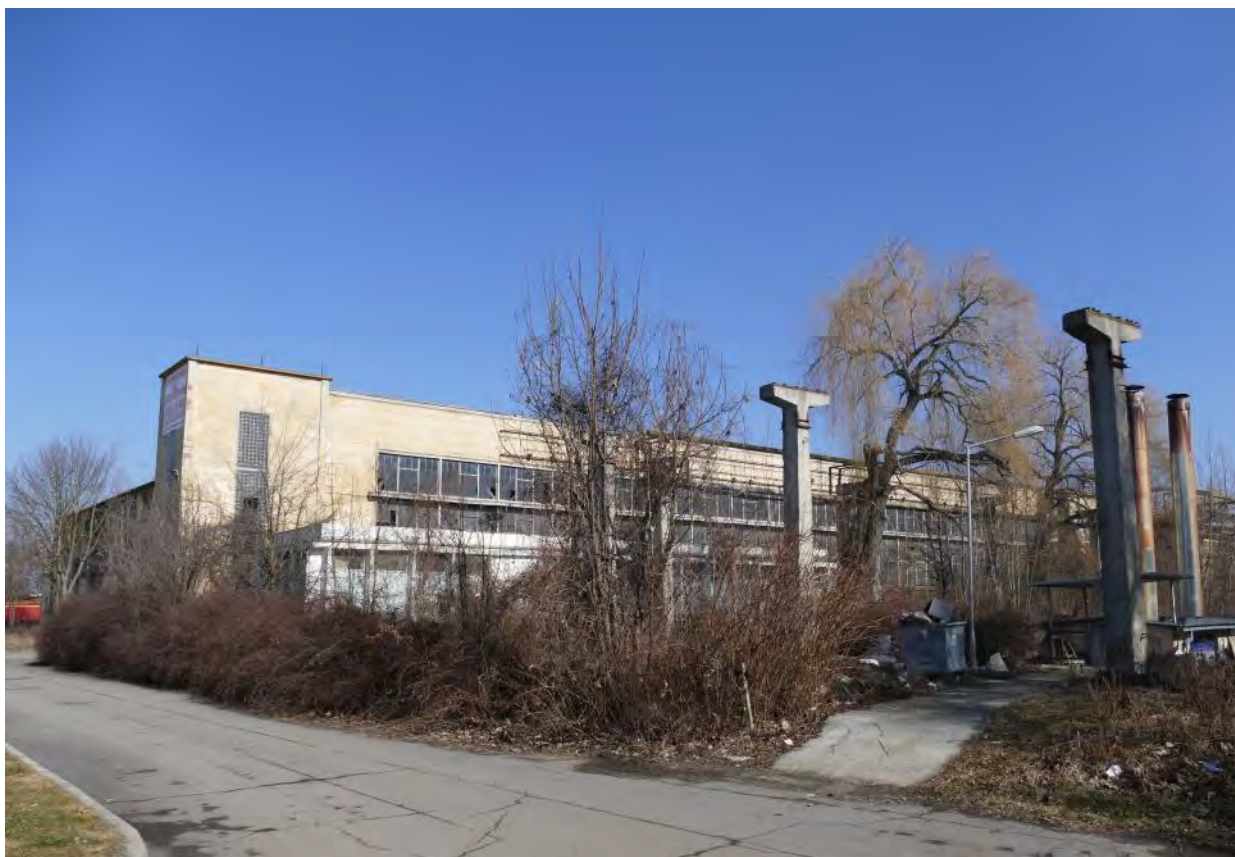
Hangarul 2 (C11) din aleea centrală
