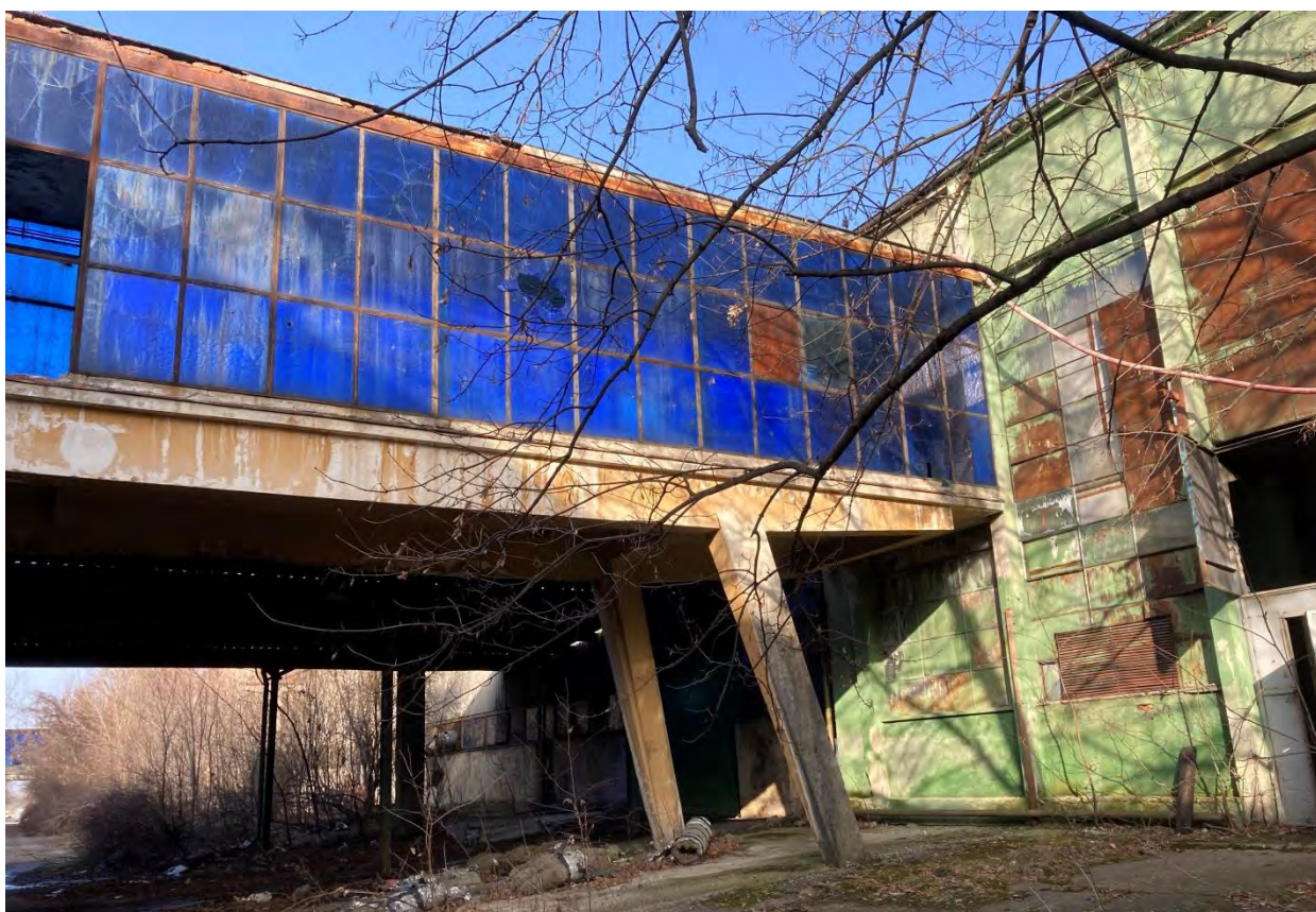
Pasarelă între hala mare (C25b) și anexa tehnică (C24)
