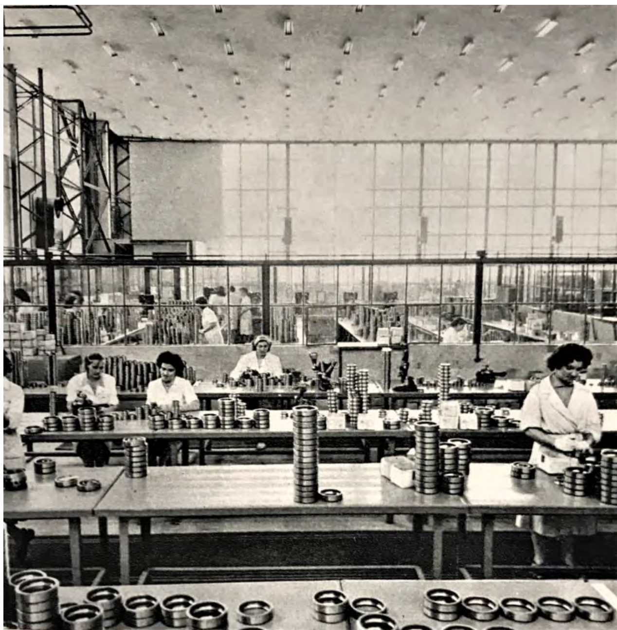
Fig. 14. Hangar transformat în hală de producție. Peretele din spatele bancurilor de lucru corespunde laturii principale (vitraj amplu, care închide deschiderile de pe latura orientată spre fostul aerodrom, la origine prevăzute cu portiere mobile).
