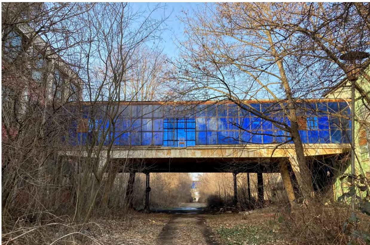
Pasarelă între hala mare (C25b) și anexa tehnică (C24)
