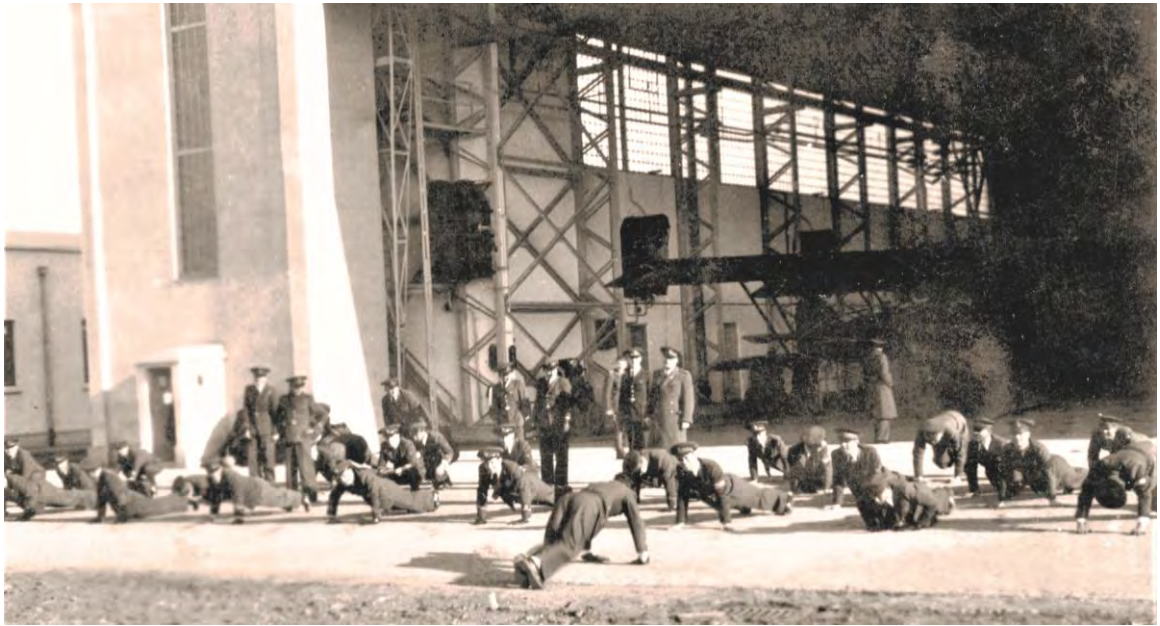
Fig. 11. Unul dintre hangare. Prin deschidere se observă structura de rezistență
