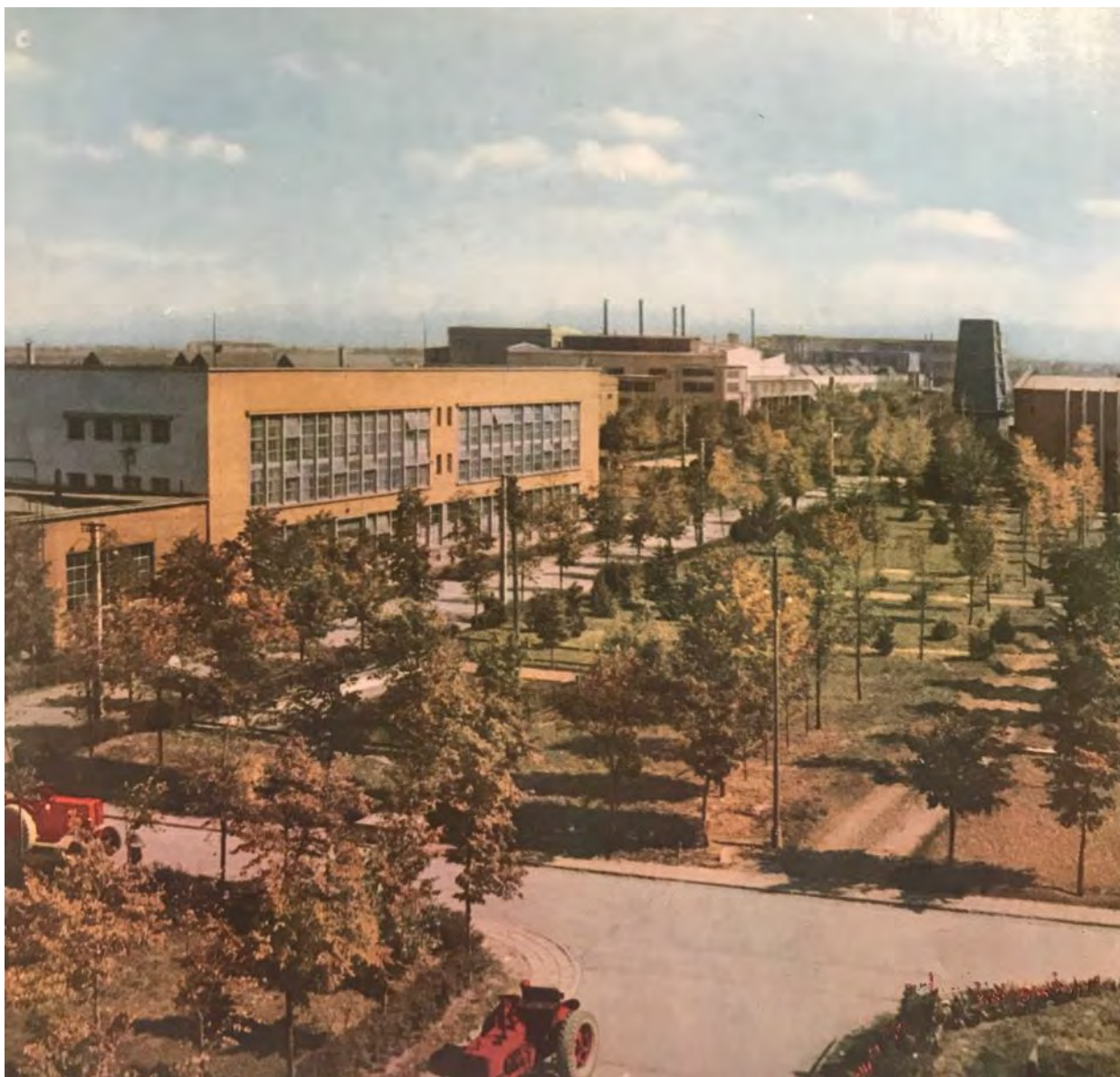
Fig. 19. Fabrica Tractorul. Amenajarea spațiului verde din incinta uzinei.
