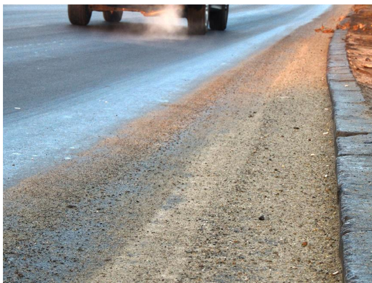
Figura 100. Mizeria care se adună în zona de circulație a bicicletelor scade aderența pneurilor și pune în pericol utilizatorii de biciclete și trotinete electrice
