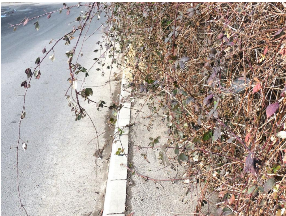
Figura 99. Vegetația neîntreținută poate obliga biciclistul să ocolească, intersectându-se cu traiectoria traficului motorizat. Alt pericol este ca vegetația să se agațe de ghidon determinând căderea biciclistului.
