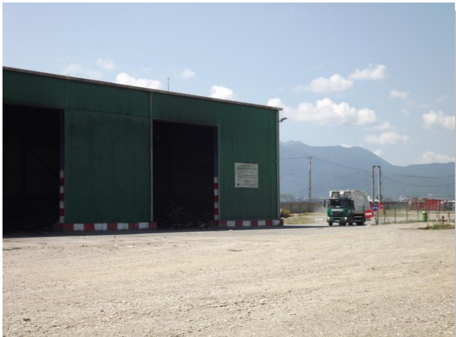
Figura nr. 7 - Hala de sortare a deșeurilor
