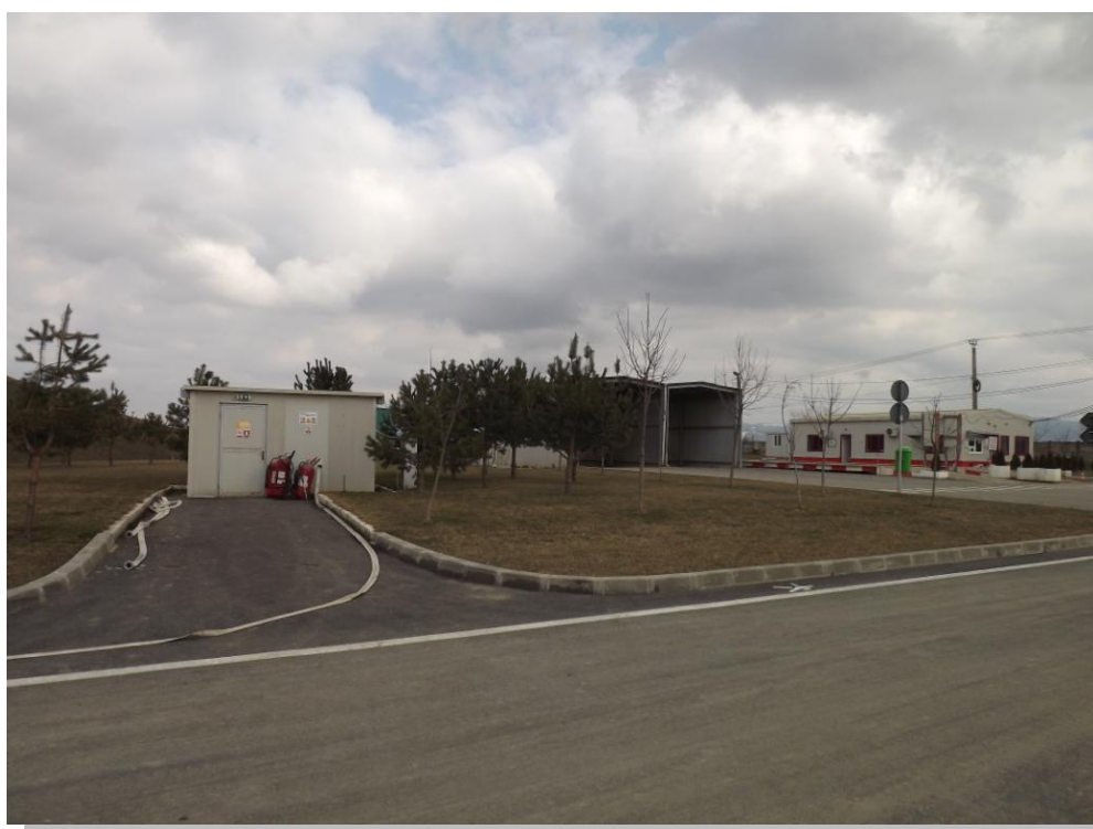
Figura nr. 3 - Rampa de spălare și dezinfecție pentru utilaje
