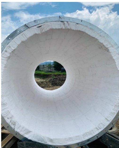
Figura nr. 3-9 Interior coș evacuare gaze arse Sursa : foto KLARVIN
