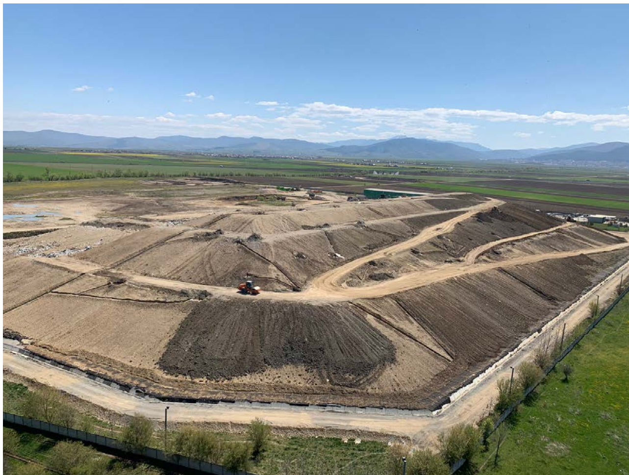
Fig. 3.1.1 – Imagine de ansamblu a celor 3 celule de depozitare deșeuri
